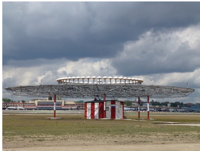
Figura 1. Doppler VOR en la terminar de un aeropuerto.
