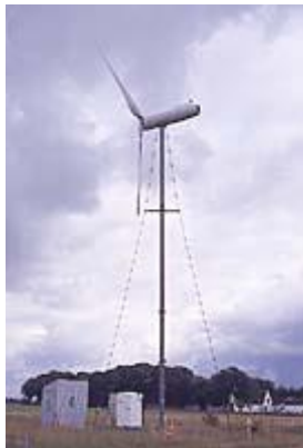
Figura 20. Torre de mástil tensado con vientos
