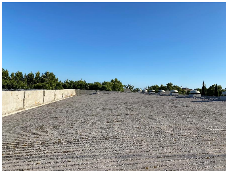
Figura 5. Imatge de l'emplaçament de la instal·lació
