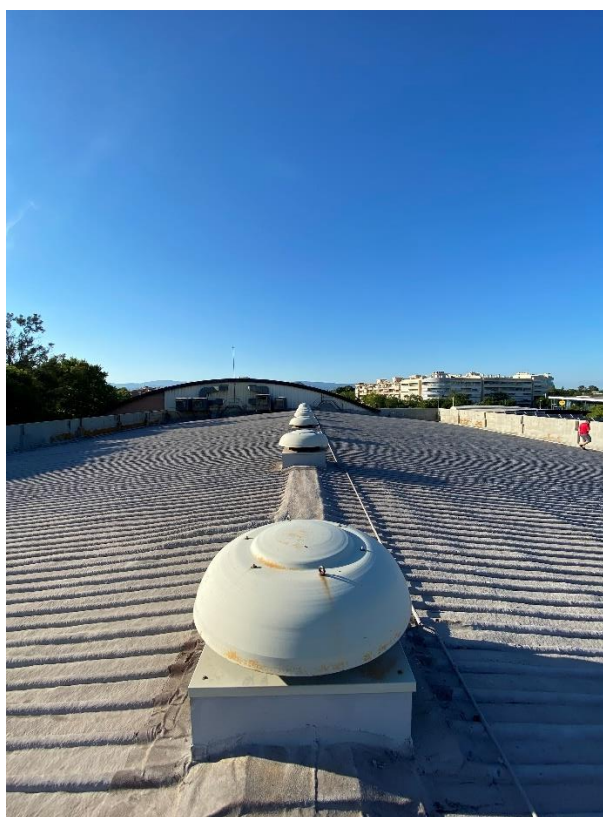
Figura 6. Imatge de l'emplaçament de la instal·lació
