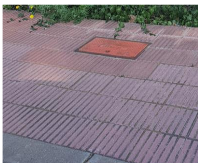
Figura 18: Hidrant a Boscos de Tarragona Font: elaboració pròpia
