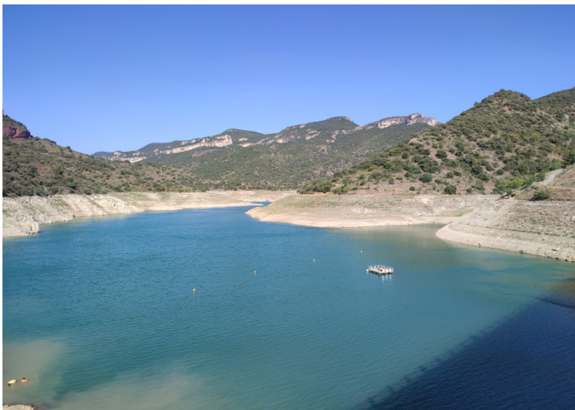
Imatge 1: Imatge general de part del pantà de Siurana.
