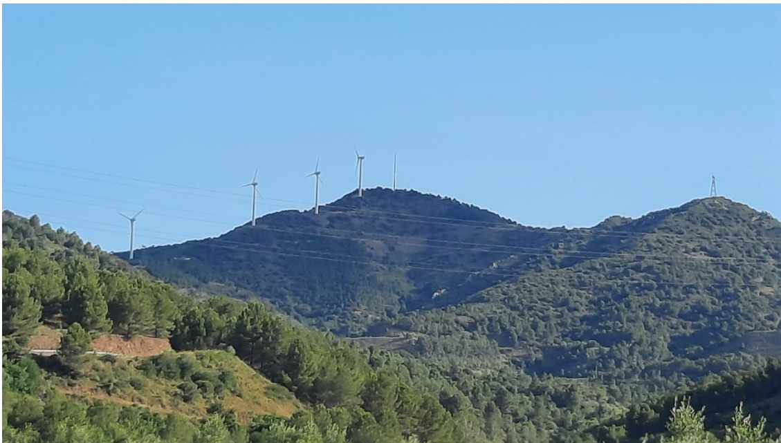
Imatge 1: Parc eòlic del Collet dels Feixos després de la seva construcció
