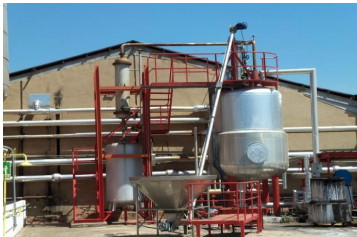
Figura 3.2.5. Planta de fabricació de pintures asfàltiques.
