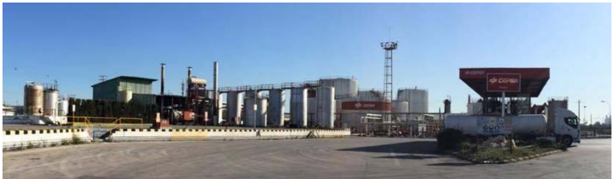
Figura 3.2.1. Imatge de la planta Cepsa Comercial Petróleo Asfaltos Tarragona.
