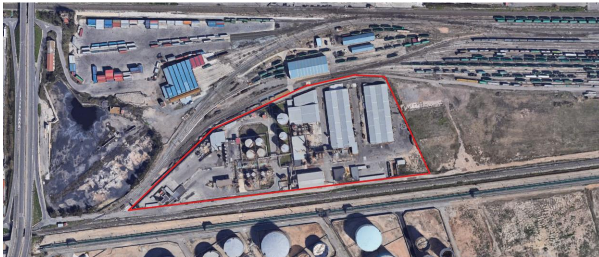
Figura 3.1.1. Vista aèria de la factoria. Extret de google.com/maps .
