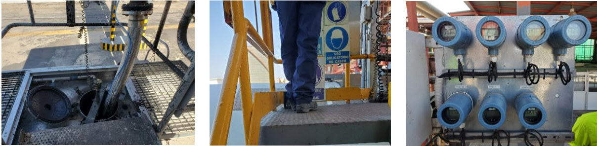
Figures. 6.2.1. 6.2.2. i 6.2.3. d'esquerra a dreta. Braç de càrrega de la cisterna, pedal accionat pel conductor i visualitzadors de nivell dels tancs.
