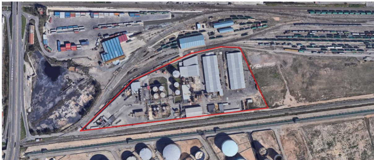
Figura 3.1.1. Vista a ria de la factoria. Extret de google.com/maps .
