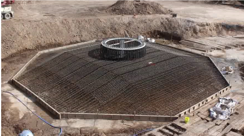
Figura 4.9 Armat inferior de base ortogonal. (Ref. 27)
