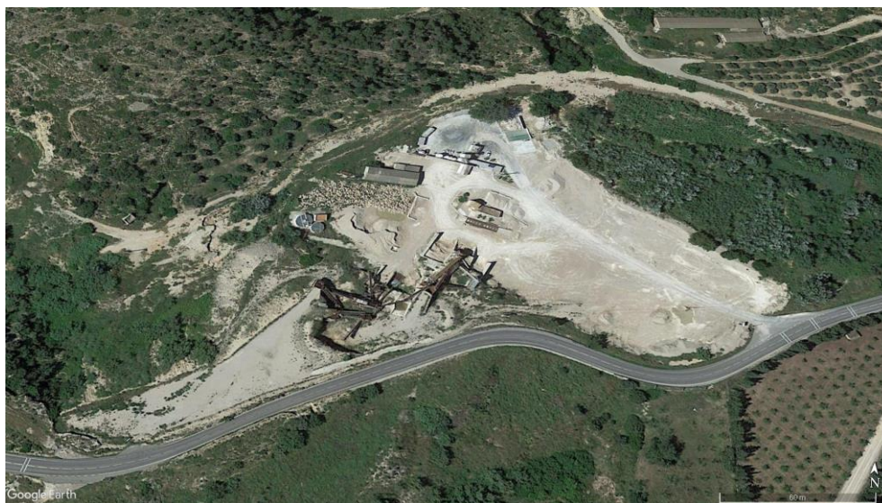
Figura 1. Imatge aèria de la planta d'àrids.
