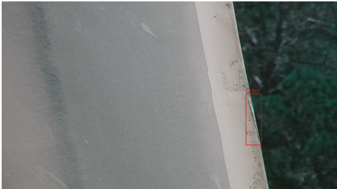
Figura 13: Exemple esqueda. Font: EbreDrone
