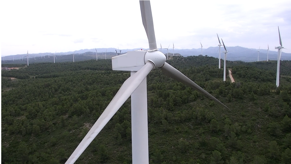
Figura 6: Aerogenerador parat per fer una inspecció amb dron. Font: EbreDrone
