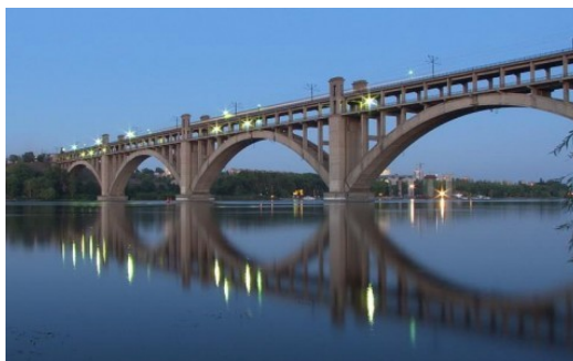
Figura 6. El pont de Zaporíyia
