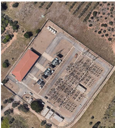
Figura 2. Imagen extraída de Google Earth de la Subestación de Bellissens.
