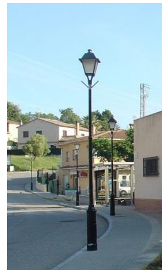
Imatge 1. Luminària existent.
