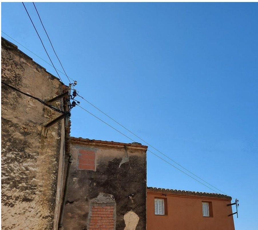
Figura 6. Fotografía de una palomilla con aisladores para el cable convencional, en el municipio de Els Garidells. Fotografía propia.
