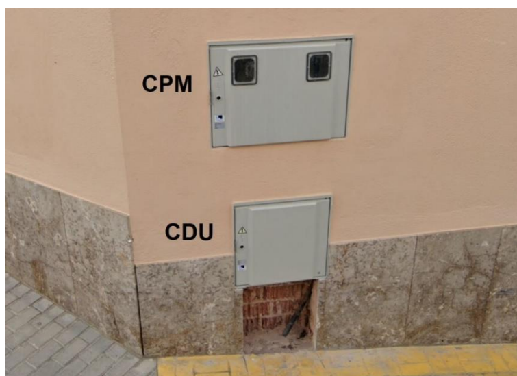
Figura 9. Fotografía de ejemplo de una CDU preparada para conectar a la red y CPM donde irá el contador. Fotografía propia.
