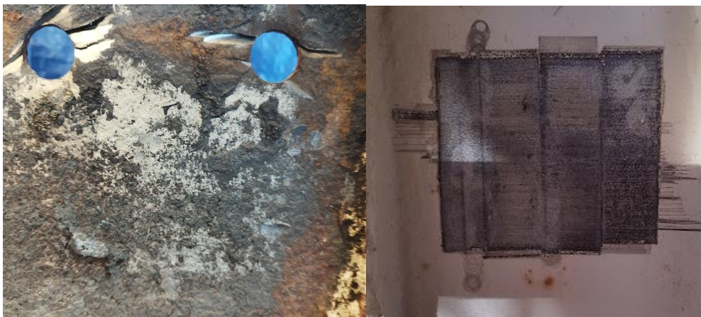
Figura 11. A l'esquerra, neteja de rovell i, a la dreta, neteja de pintura metàl·lica.
