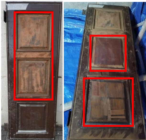
Figura 8. Porta de finestra dels pavellons Güell amb parts decapades, a l'esquerra, i amb aplicació làser, a la dreta.
