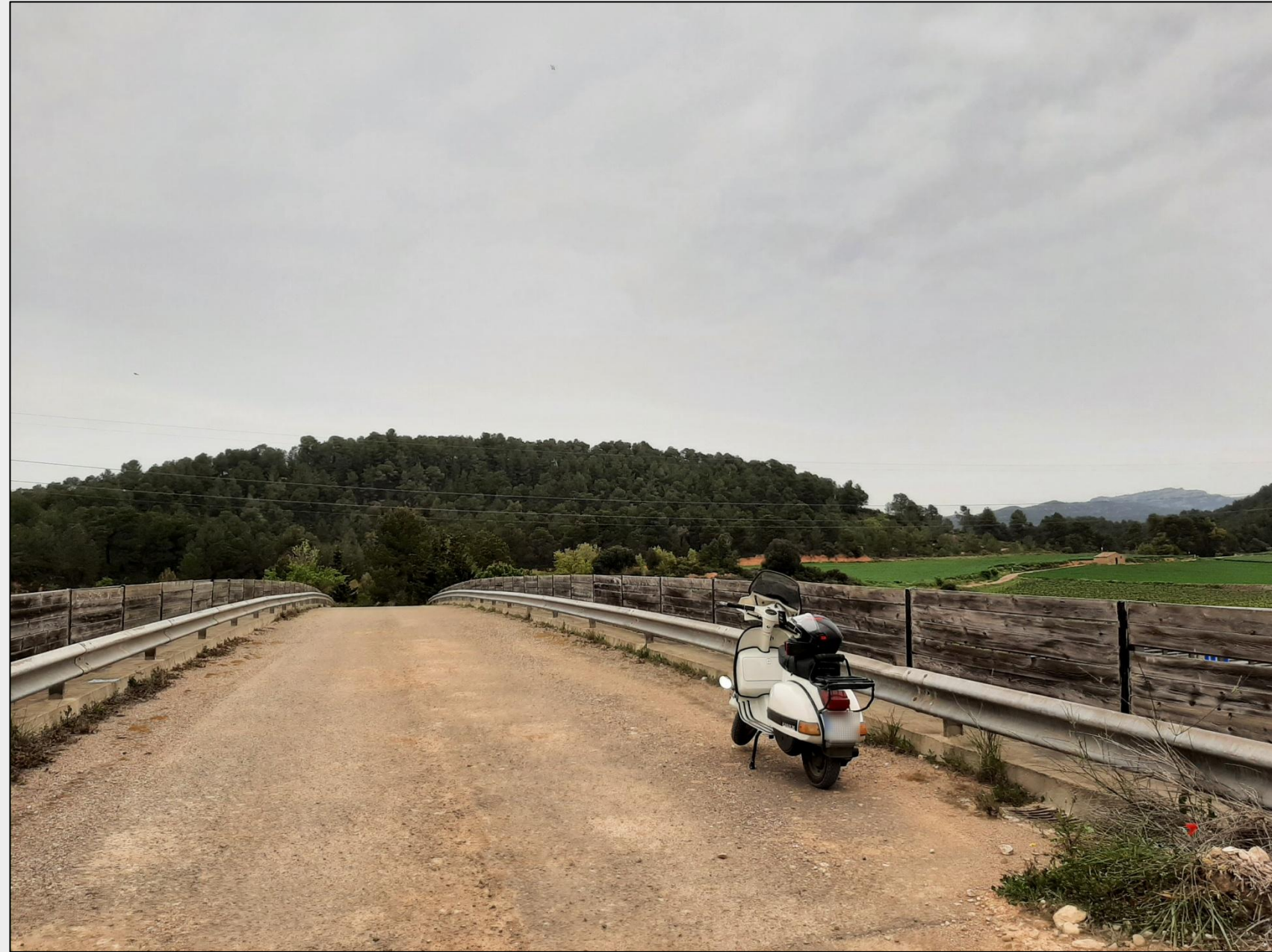
Pas superior multifuncional a la AP-2, Barberà de la Conca, 2025. X: 353962,21, Y: 4583688,67 (UTM Zona 31N) Font: Elaboració pròpia.
