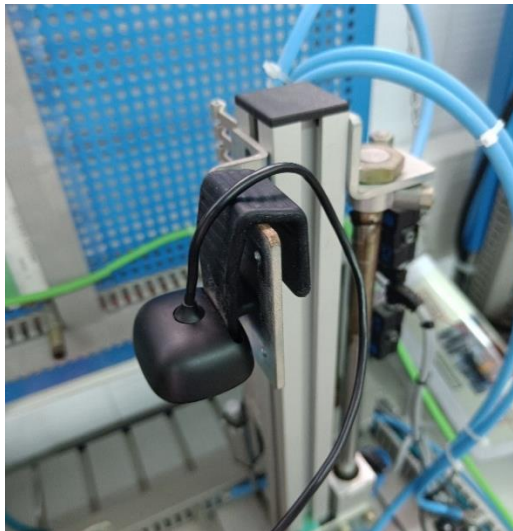
Fig. 78: Instal·lació de la webcam a la planta. Font: realització pròpia.
