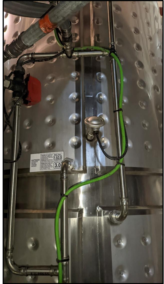
Il·lustració 10: Electrovàlvules i sensor temperatura
