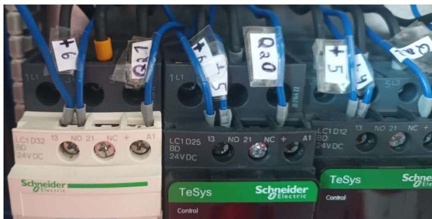
Figura 73: Exemple de connexió de control dels contactors.
