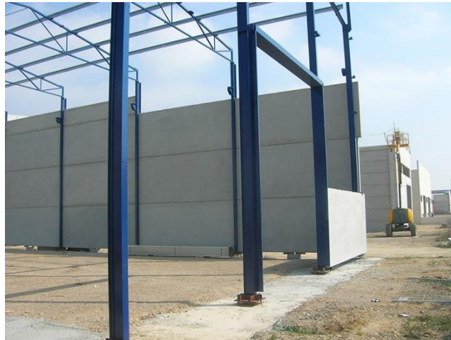
Figura 42. Panells de formigó prefabricat
