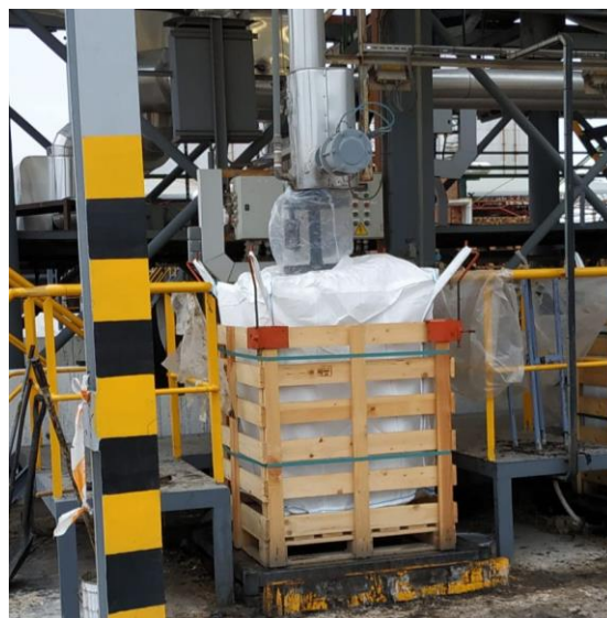
Figura 2.2. Zona actual de llenado de big bags .
