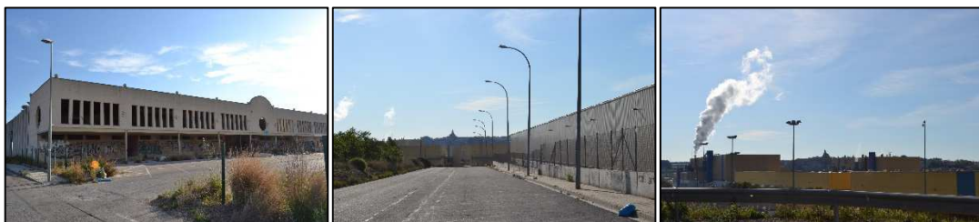
Figura 34. Fotografies del polígon monoindustrial de Puigpelat
