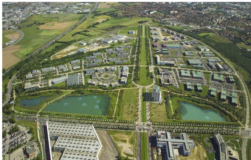
Figura 2. Vista aérea del Parc technologique de Lyon
