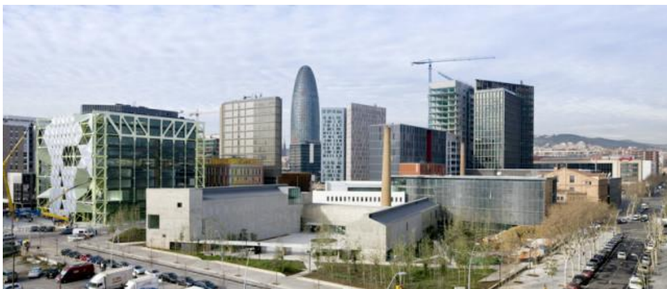
Figura 60. Algunos de los edificios más icónicos del Distrito 22@ de Barcelona
