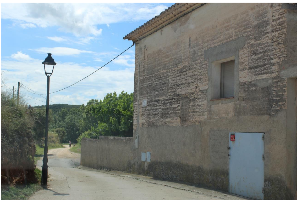
Imatge 49. Edificacions pròximes a la carrerada.
