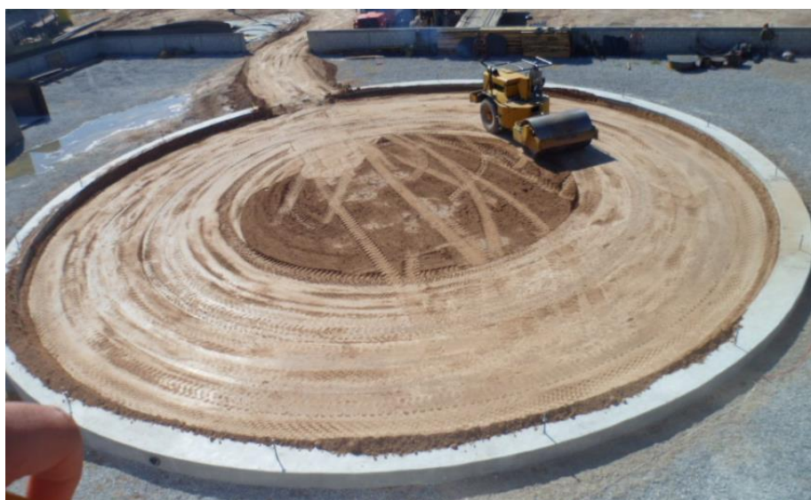
Figura 6. Anillo de cimentación de hormigón armado tanque.
