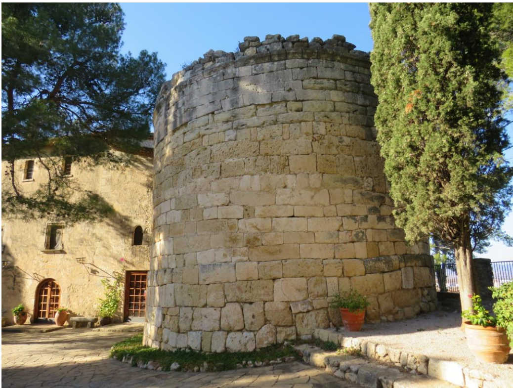
Figura 80. Vista general de la Torre de les Gunyoles, amb l'edificació dels ss. XIV-XV coneguda com "El castell". (Elaboració pròpia).
