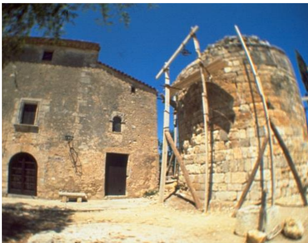
Figura 13. Restauració del monument durant el transcurs de col·locació de les noves peces de la cornisa, quan ja s'havien tapat els orificis del sector S (Fotografia inèdita cedida per Ignacio Umbert Millet, dins de l'arxiu particular de la família Umbert).
