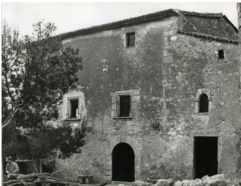
Figura 83. Can Rialb poc abans de les reformes efectuades a la planta superior. La Torre ens apareix en primer pla a la dreta, mesos abans de l'inici dels primers treballs de consolidació. [Expedient fotogràfic cedit per Pilar Torressana (febrer 1967). Número d'entrada 59-927, Arxiu documental Servei de Patrimoni Arquitectònic Local (SPAL)].
