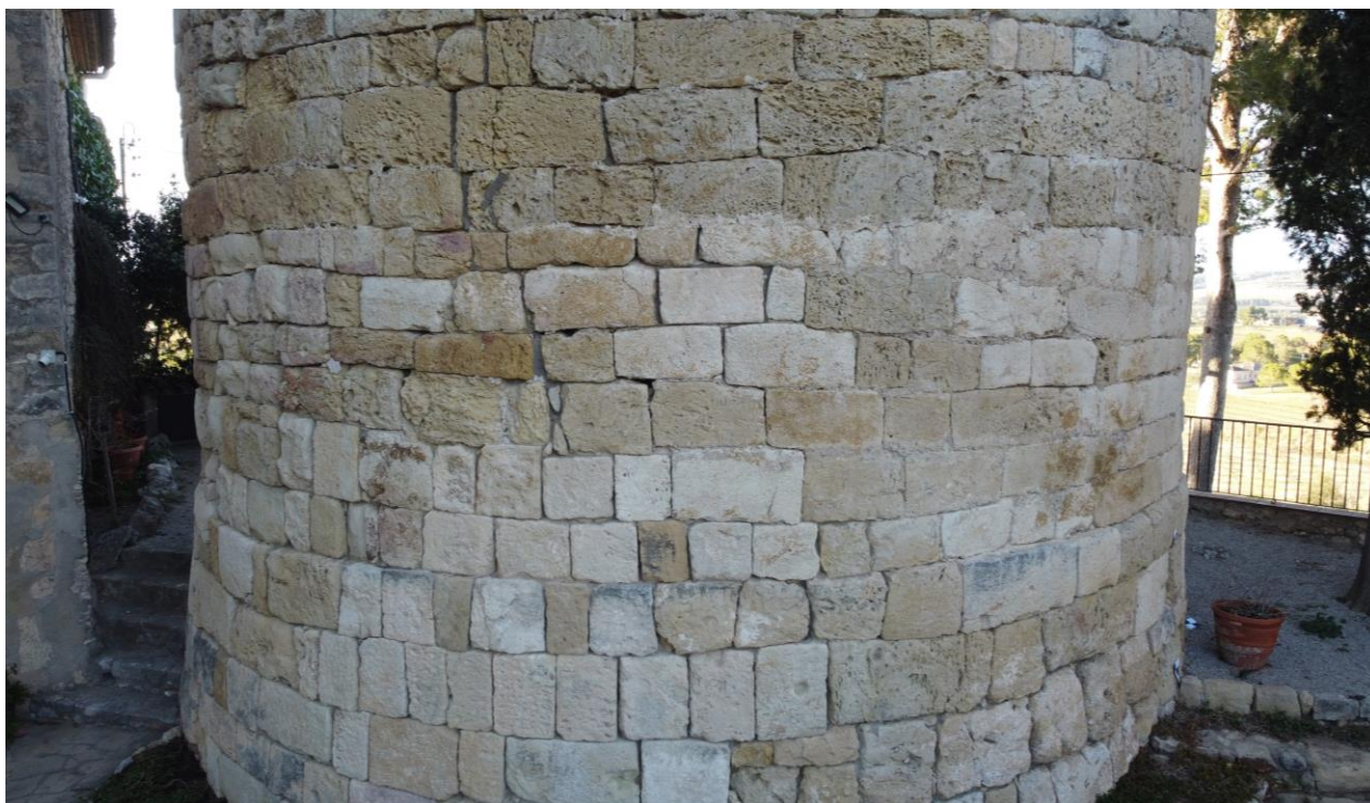
Figura 87. Vista frontal del primer cos des del jardí de la finca, on el pas del temps, les restauracions i la fragmentació dels carreus han desdibuixat el característic parament original (Elaboració pròpia).
