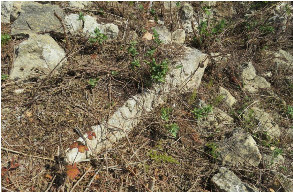
Figura 17. L'enderroc a la part superior deixa entreveure la cara interior del mur del segon cos de la torre, en aquest cas al sector N, amb un únic bloc que emergeix de les restes (Elaboració pròpia).
