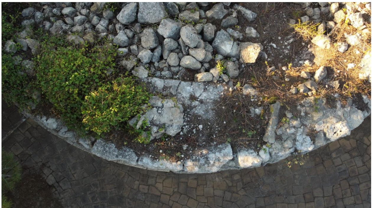
Figura 66. Vista zenital del sector S on trobem les restes del mur corresponent al segon cos de l'edifici (Elaboració pròpia).
