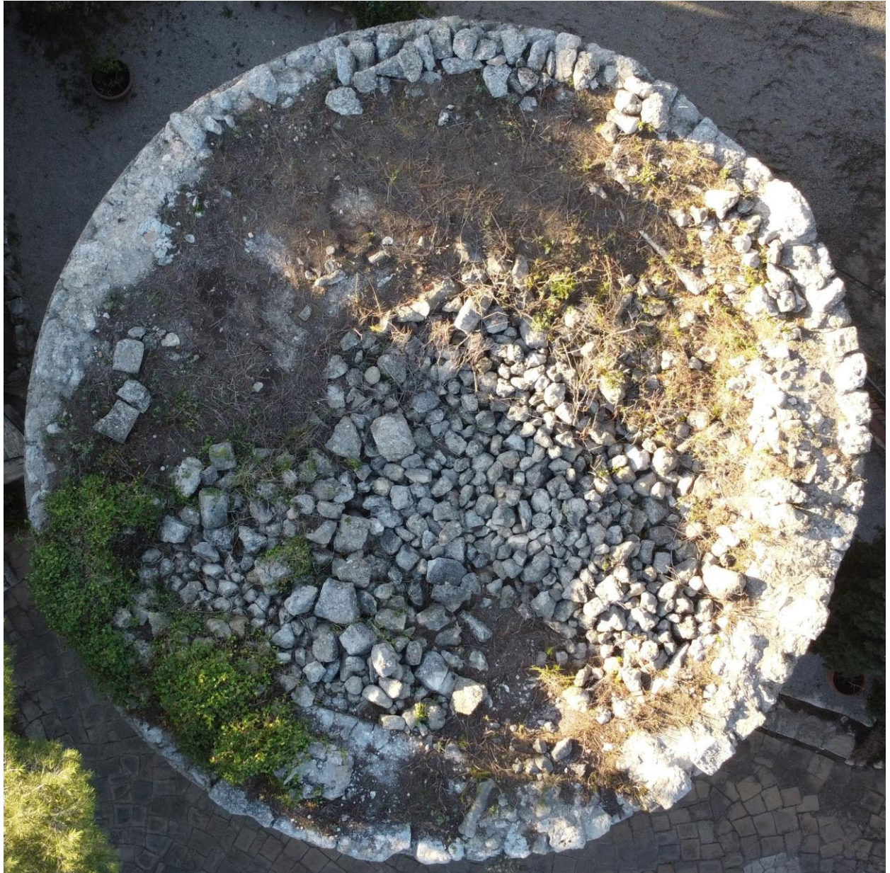
Figura 11. Vista zenital de la Torre de les Gunyoles (Elaboració pròpia).
