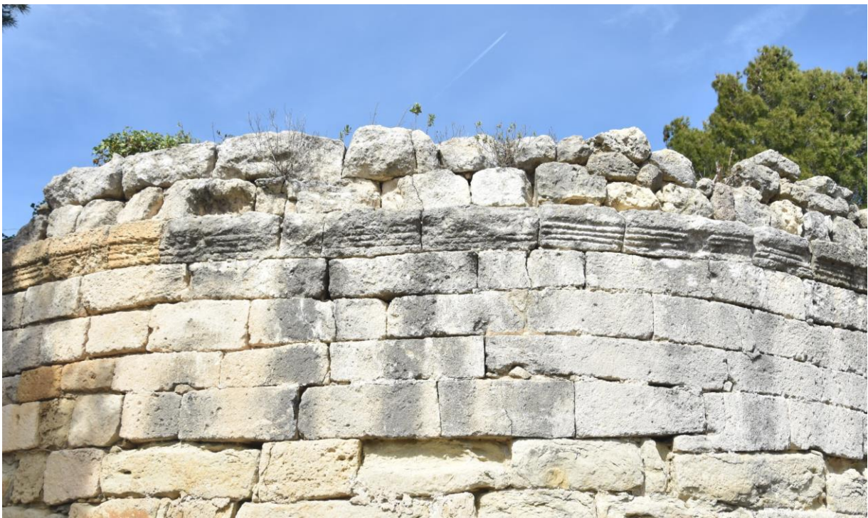
Figura 48. Part superior del sector SE, amb fins a 6 carreus de la cornisa original (Elaboració pròpia).
