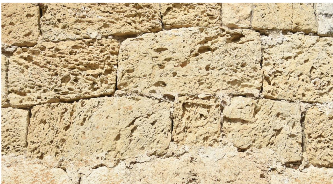
Figures 59 i 60. Les filades 7 i 8 sobre el sòcol presenten un índex important d'erosió alveolar (Elaboració pròpia).
