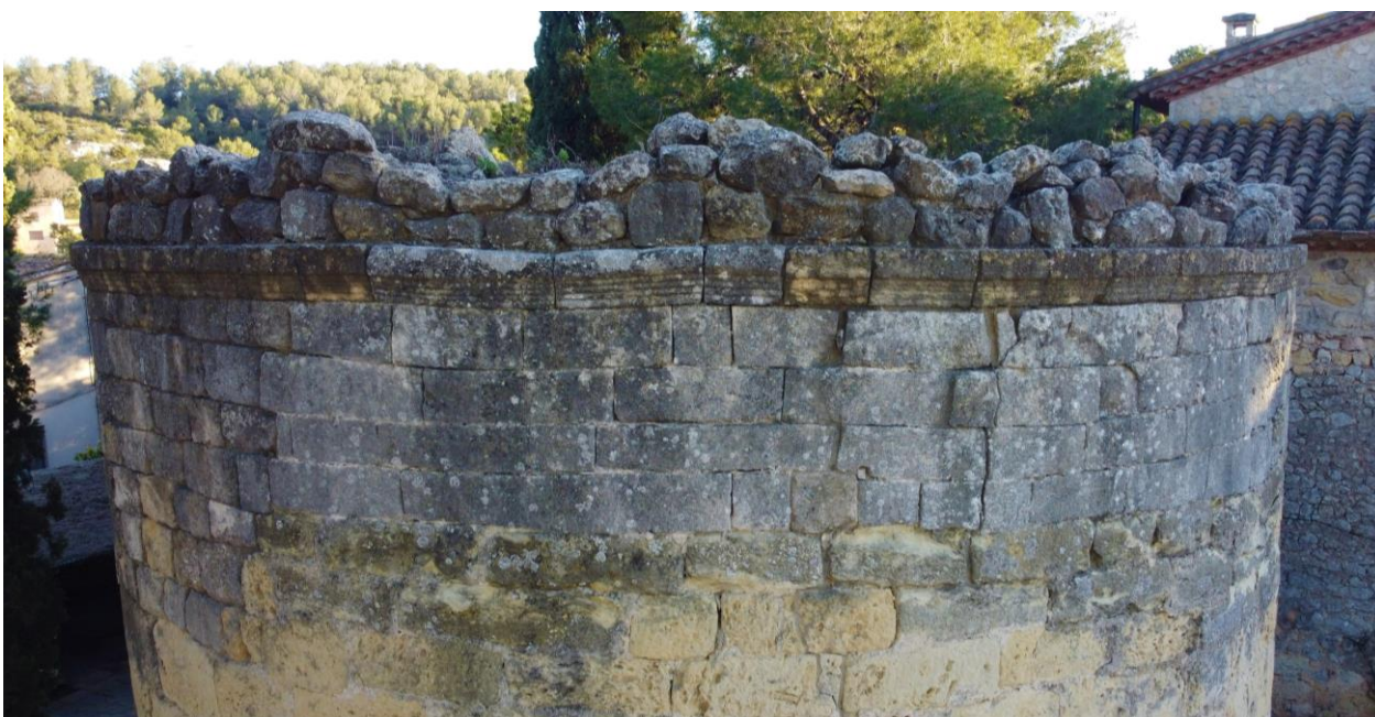
Figura 10. Part superior de la cara N de la Torre de les Gunyoles, amb presència d'un sector de cornisa original (Elaboració pròpia).
