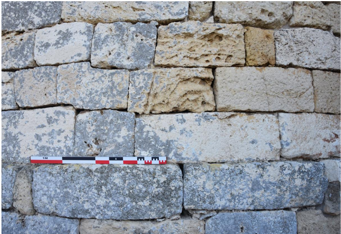
Figura 90. Aparell d' opus quadratum tosc (Elaboració pròpia).
