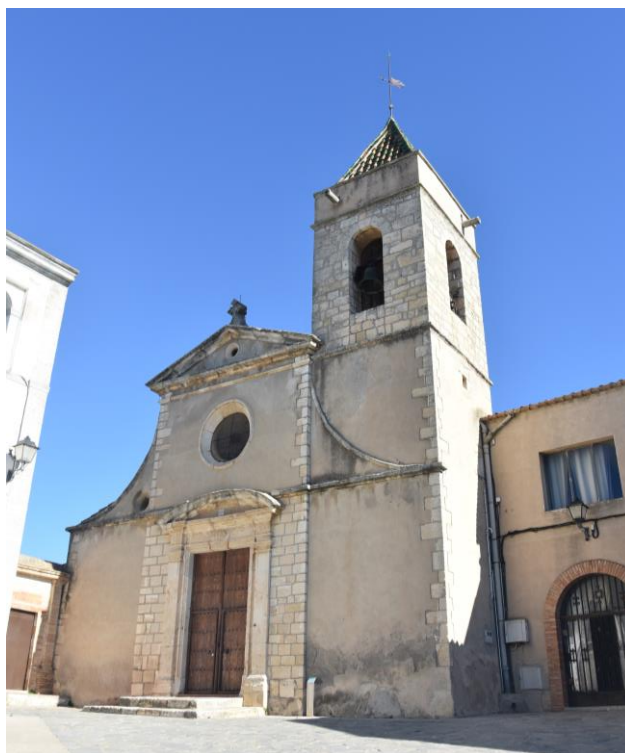
Figura 86. Església parroquial de Sant Salvador de les Gnyoles -s. XVIII-, situada a menys de 100 m de la Torre de les Gnyoles. El campanar es va erigir amb els carreus extrets del segon cos de la torre. Pel que ens indica la data situada en la llinda de l'accés, aquesta va ser finalitzada l'any 1776 (Elaboració pròpia).
