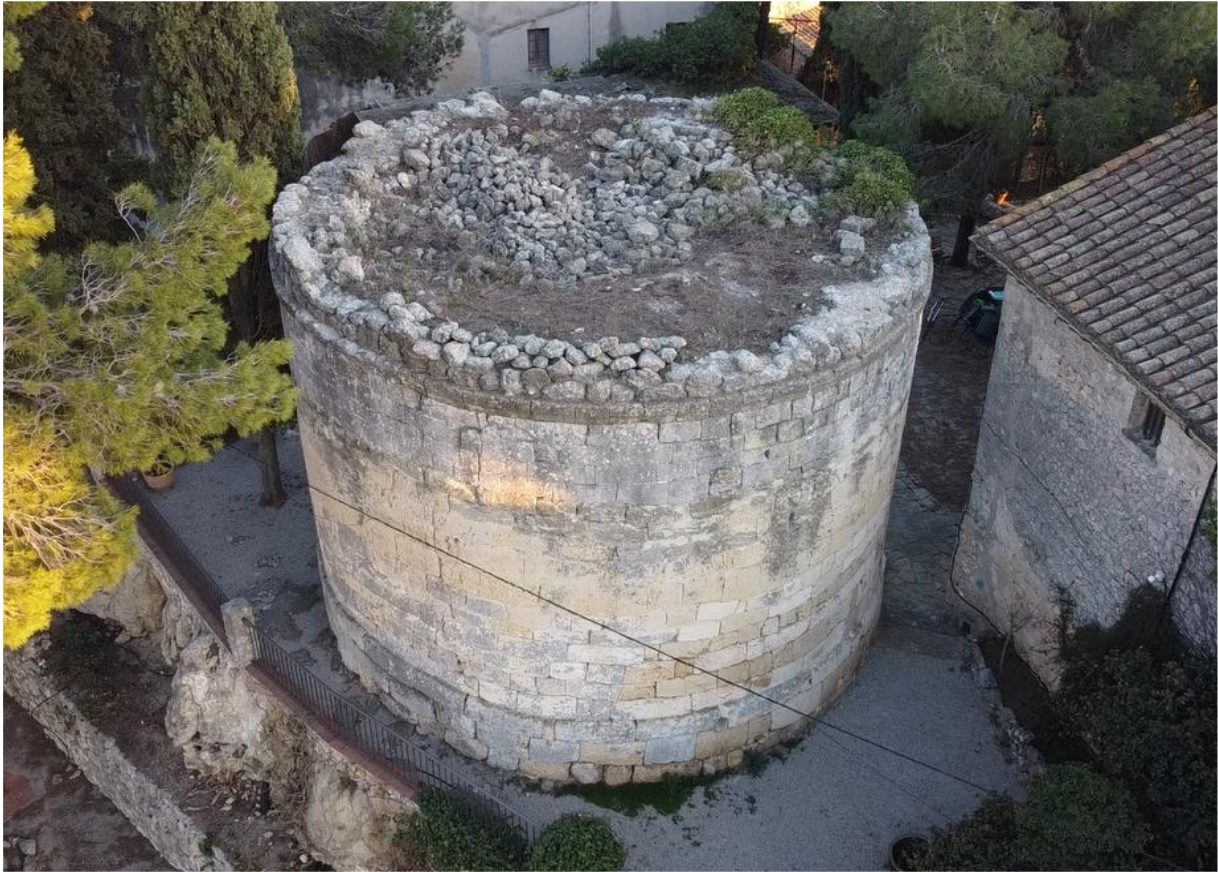
Figura 12. Vista aèria del monument, on es pot observar perfectament com s'assenta sobre la roca natural i la distància de l'element amb el marge rocós (Elaboració pròpia).
