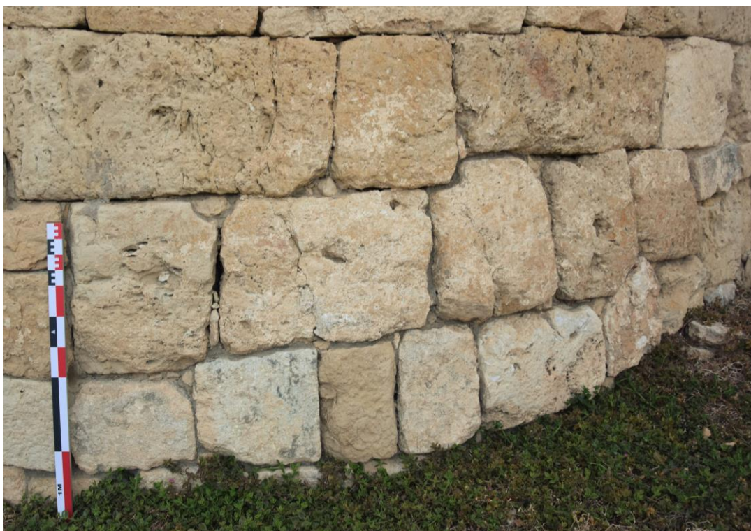
Figura 54. En la cara SE trobem el sòcol molt lleugerament atalussat, dels quals les quatre primeres filades -la primera i la segona queden semiamagades sota la vegetació- formaven part de la fonamentació i, per tant, cobertes de terra. Els carreus centrals de la imatge -filada -3- presenten un treball picapedrer descurós, que no s'observa en cap altre carreu de la torre, evidenciant encara més que en el moment original es trobarien soterrats. (Elaboració pròpia).
