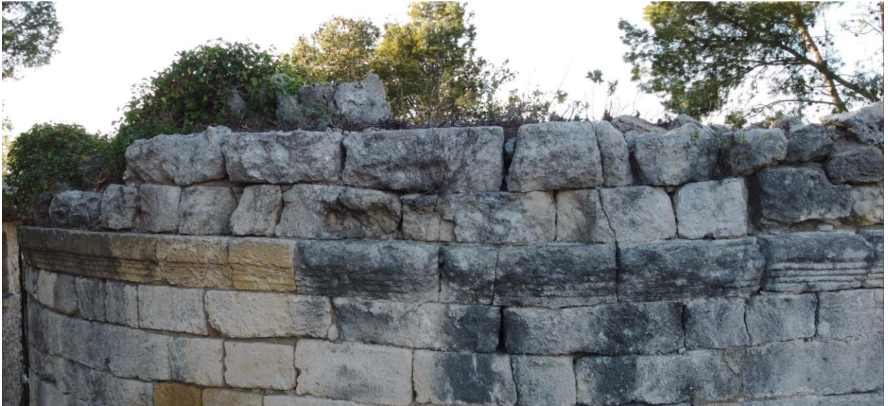
Figura 65. Sobre la cornisa, aquest és l'únic sector on es conserven dues filades de carreuat original (Elaboració pròpia).
