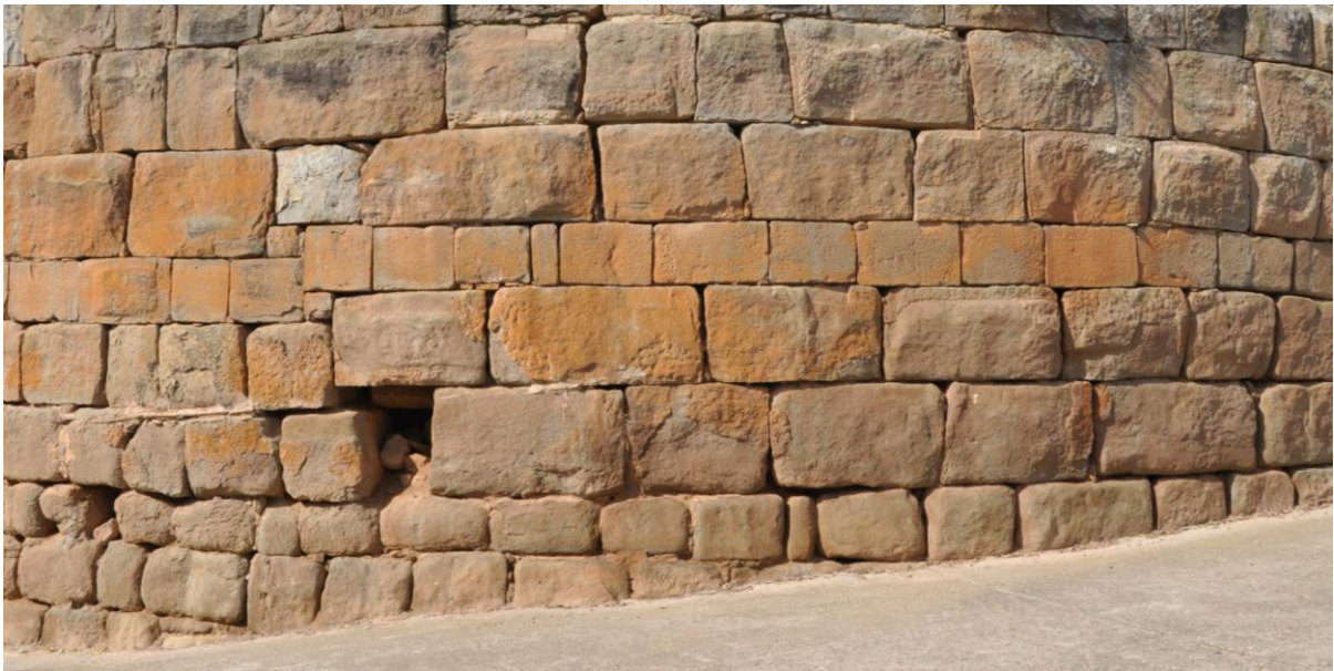
Figura 52. Parament d' opus quadratum del Castell-Lliuró de Castellnou d'Ossó (Ossosio.ddl.net. Castellnou d'Ossó ).
