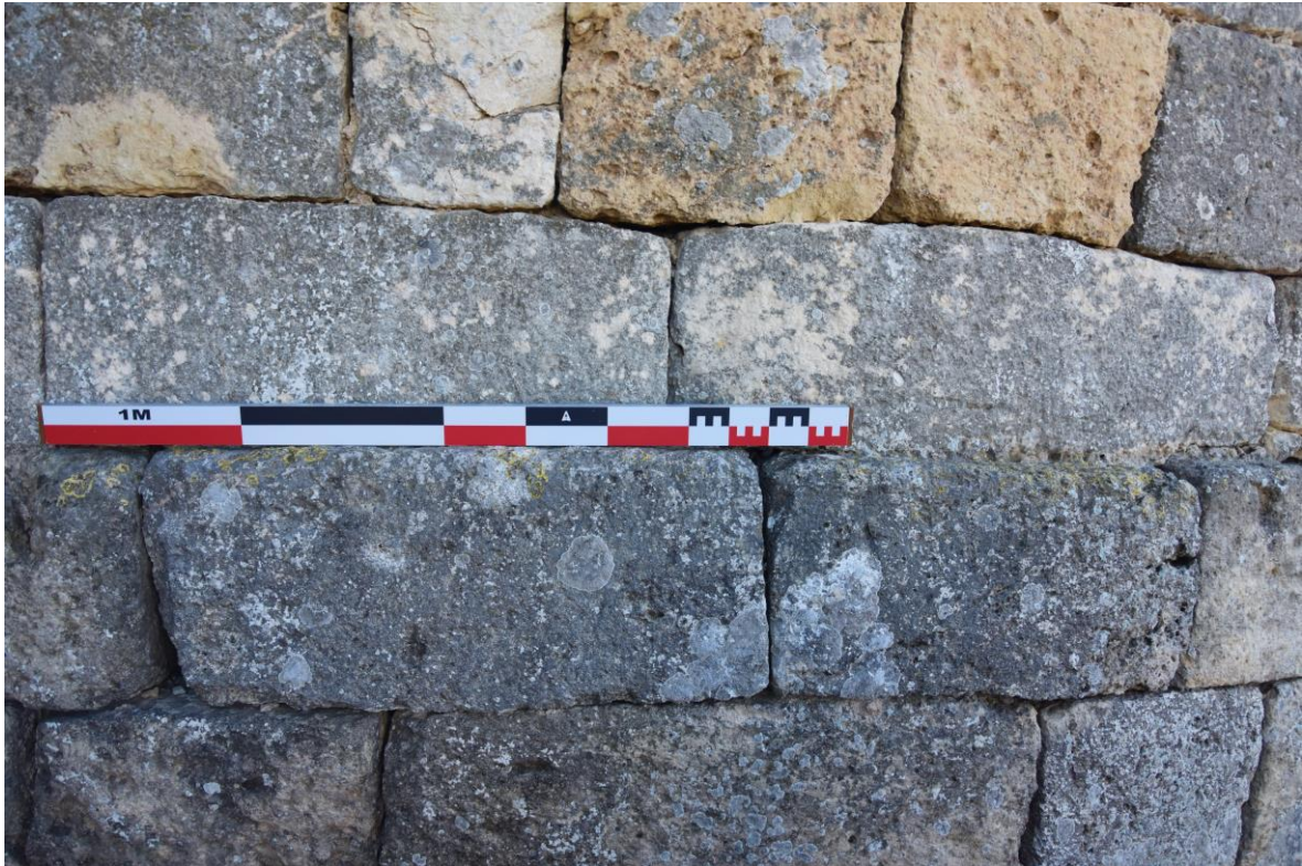
Figura 88. Disposició dels carreus entre el sòcol i l'inici del primer cos (Elaboració pròpia).
