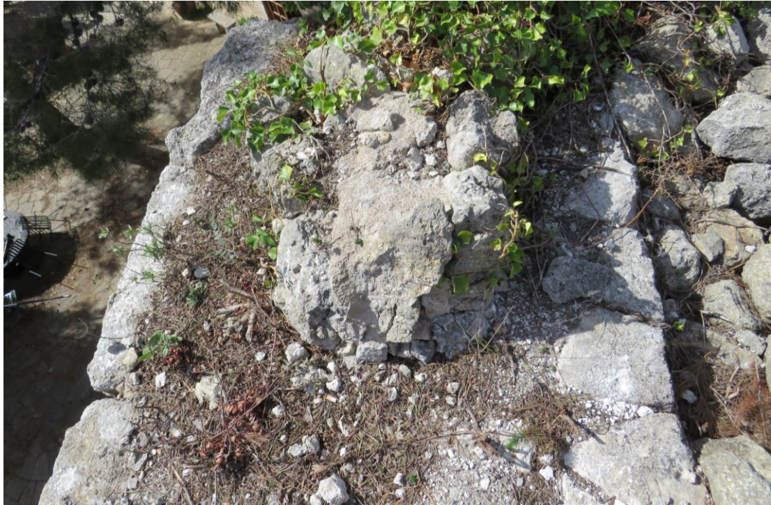
Figura 16. Mur d'1,4 m corresponent al segon cos de la Torre de les Gunyoles, on podem observar la cara externa amb alguns dels pocs carreus originals conservats per sobre la cornisa i la cara interna d'aquest. Al centre, tenim l' opus caementicium original, mesclat amb morter de la restauració del 1967-68 (Elaboració pròpia).
