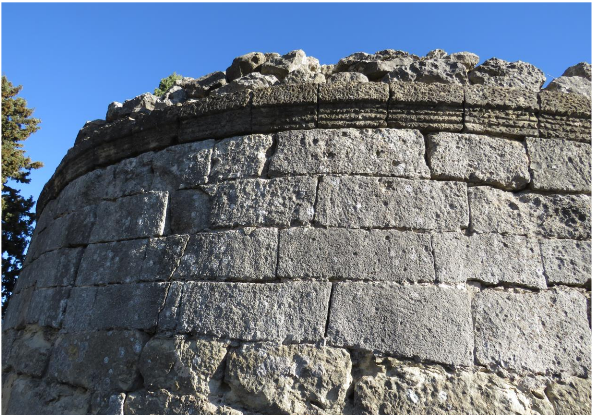
Figura 63. Detall de les cinc filades sota la cornisa al sector NW, amb un estat de conservació considerable (Elaboració pròpia).
