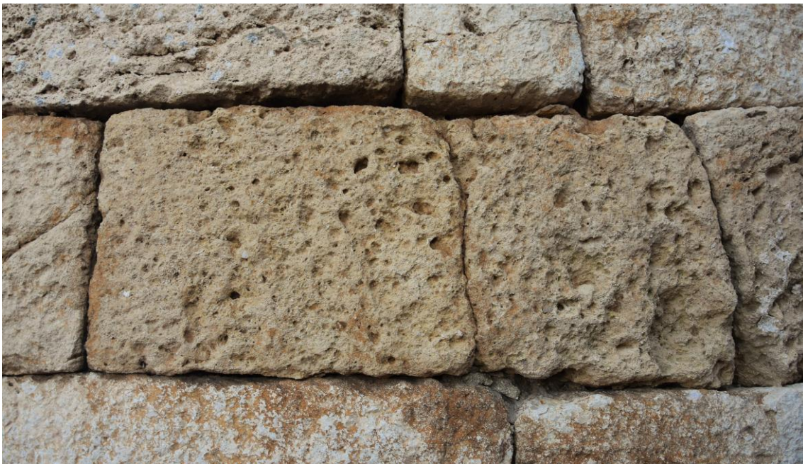
Figura 46. A la torre trobem una quantitat important de carreus fragmentats que distorsionen la morfologia del carreuat original. En aquí trobem un carreu esquarterant-se en una fase molt primerenca (Elaboració pròpia).
