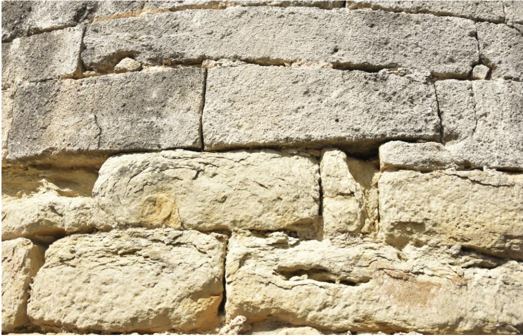
Figura 62. Filades 10 a 13 on s'observa el canvi de qualitat en els carreus a través principalment de la seva degradació. A la carreuada 12 -dreta de la imatge- trobem el singular carreu engatillat (Elaboració pròpia).
