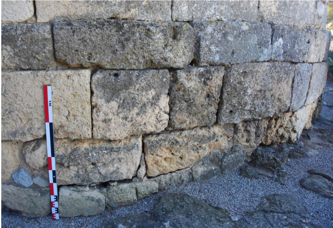
Figura 55. Sòcol del sector NE. A la dreta s'observa clarament com s'assentà directament l'estructura a l'aflorament rocós (Elaboració pròpia).
