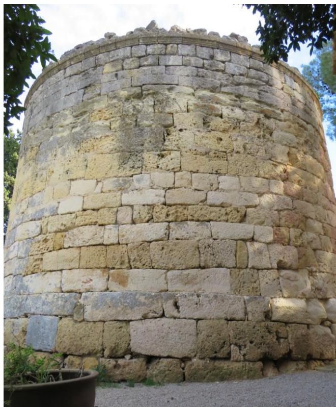
Figura 82. Vista de la cara W a NW (Elaboració pròpia).
