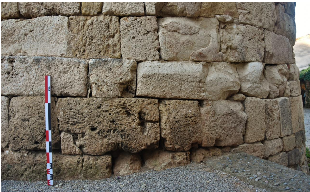
Figura 9. Vista del sòcol en el sector W (Elaboració pròpia).
