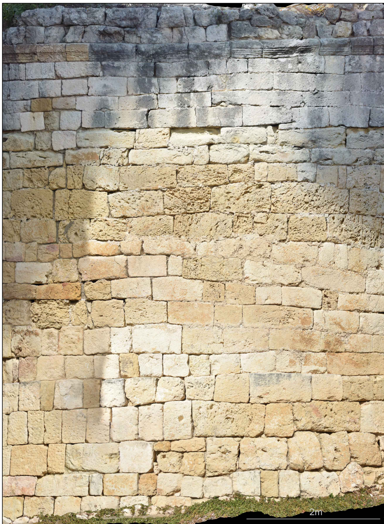
Figura 42. Ortofotomosaic del sector SE, on podem observar alguns dels carreus originals d'arrencament del segon cos (Elaboració pròpia).
