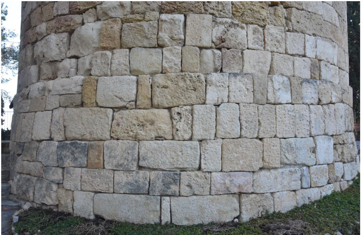
Figura 95. Àrea reconstruïda el 1967-68, corresponent al sector S de la torre. Abans d'aquesta intervenció, aquí hi trobàvem els dos grans orificis corresponents a dues estructures productives (Elaboració pròpia).
