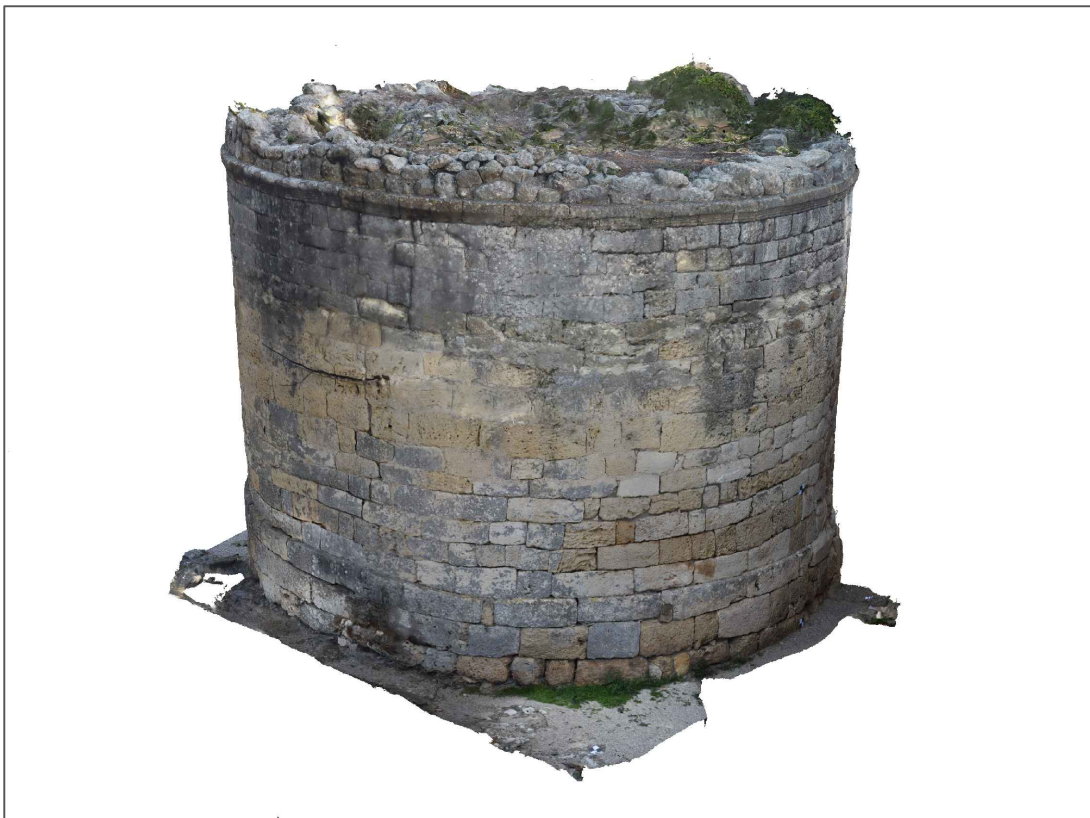
Figura 31. Resultat definitiu del model fotogramètric digital (Elaboració pròpia).
