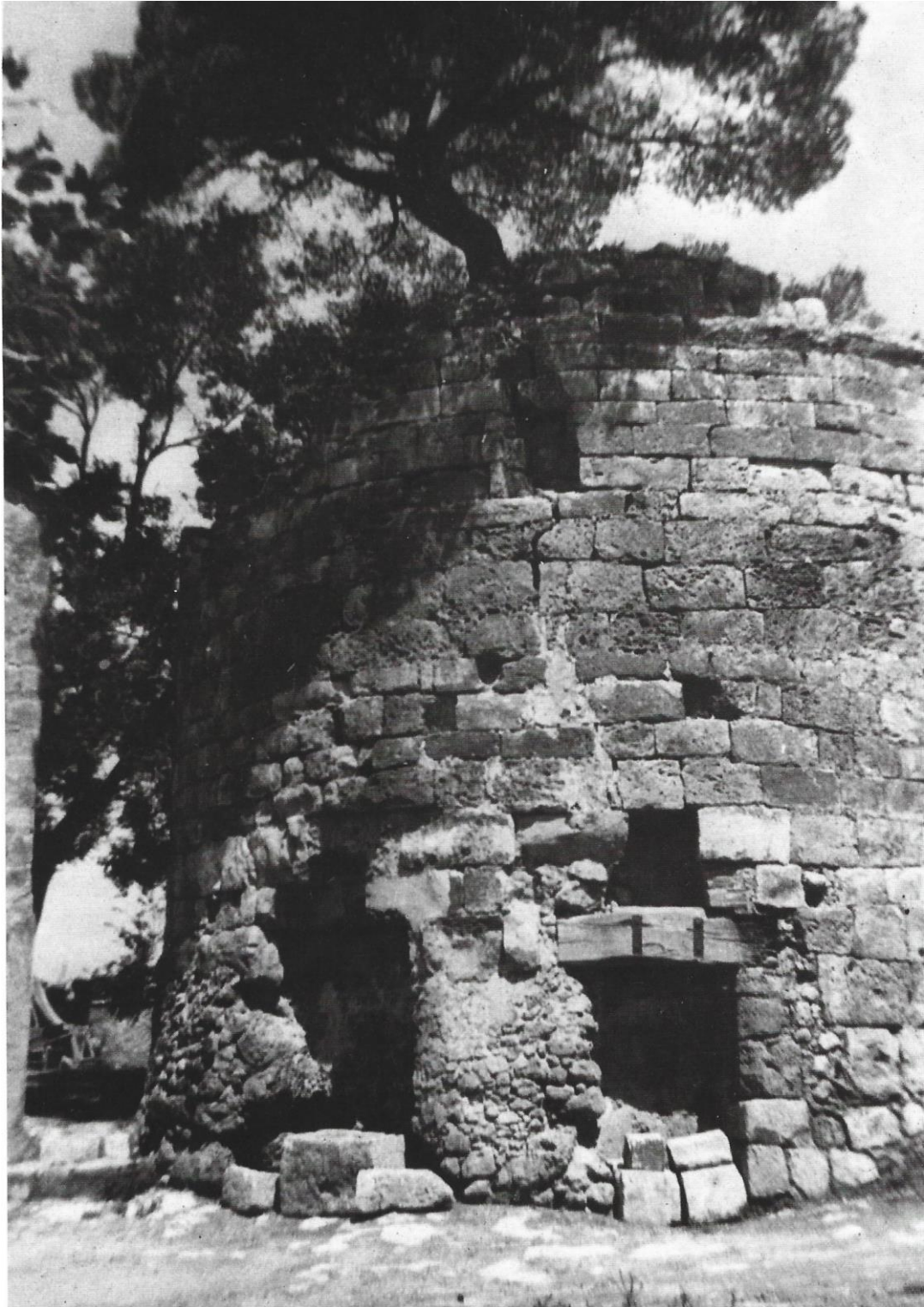
Figura 19. Façana sud de la Torre de les Gunyoles en un moment indeterminat durant la primera meitat del s. XX. Es poden observar les dues grans perforacions destinades a l'espai productiu -font a l'orifici de l'esquerra i premsa de vi a l'orifici de la dreta- (Guilera, 2018, 294).
