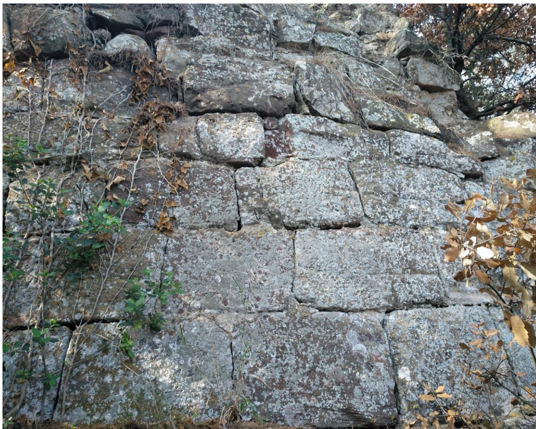
Figura 22. La torre mestra del Castell de Sant Jaume -Castellví de Rosanes, Baix Llobregat-, es tracta d'una de les edificacions compresa dins de la "problemàtica de les torres aïllades", sent un paral·lel clar de la Torre de les Gunyoles (Elaboració pròpia).
