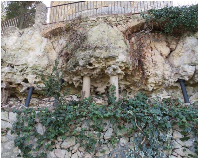
Figura 21. Vista parcial de l'esperó rocós del qual se sustenta la Torre de les Gunyoles, amb una sèrie d'apuntaments, dels quals els metàl·lics -en negre- han estat col·locats el 2022 (Elaboració pròpia).
