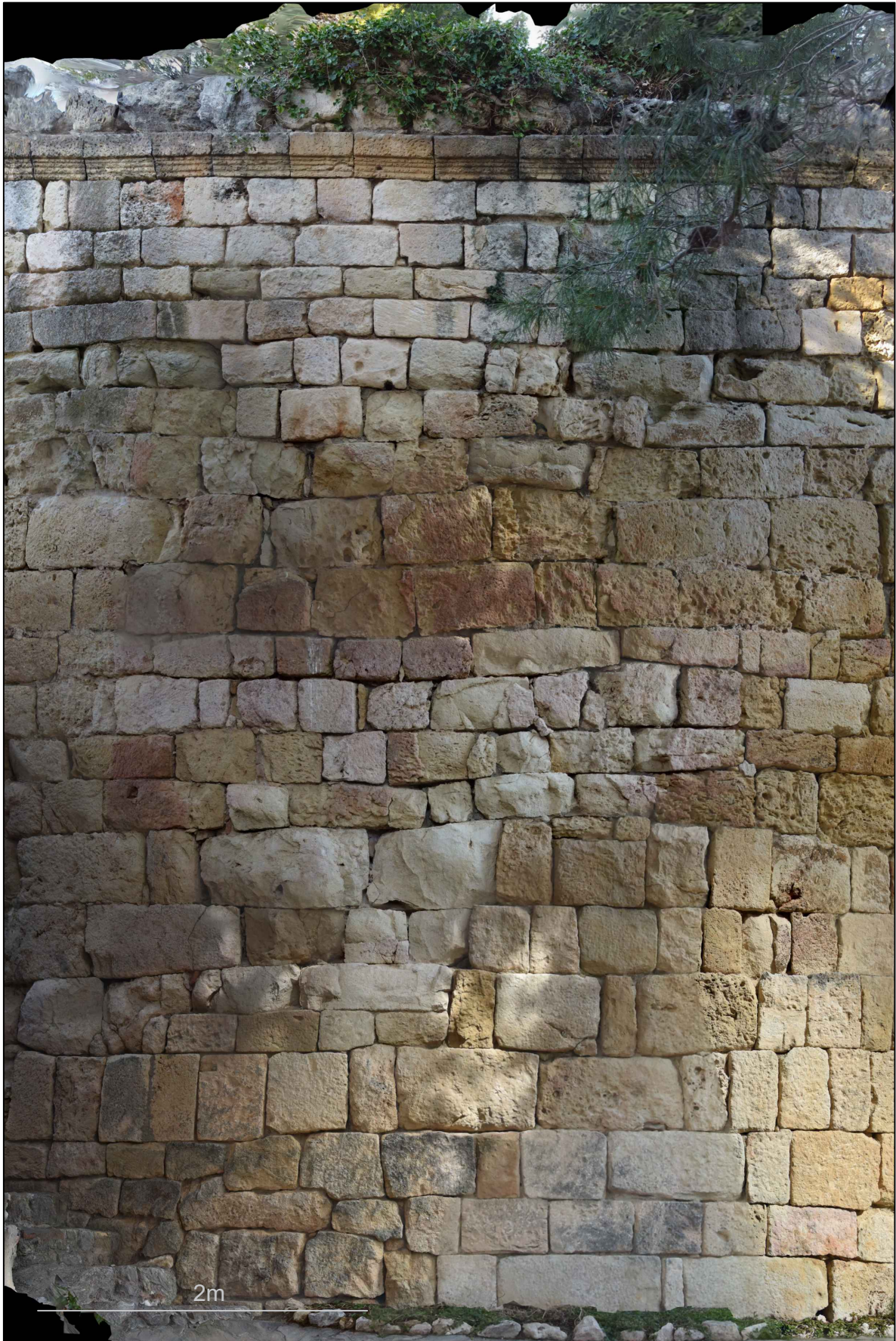
Figura 41. Ortofotomosaic del sector SW, el més degradat del conjunt (Elaboració pròpia).
