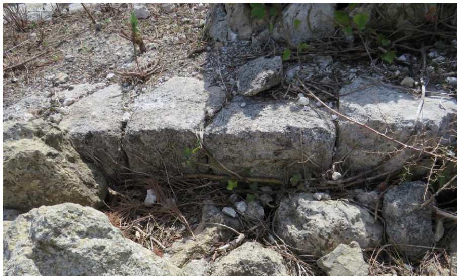
Figura 15. A la part superior encara es poden observar els carreus corresponents al mur interior del segon cos -sector S-. Sota d'aquests tenim quatre filades més fins arribar al nucli macís d' opus caementicium (Elaboració pròpia).
