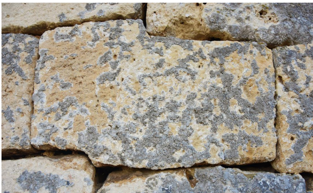
Figura 58. Carreu esglaonat situat en la segona filada sobre el sòcol, al sector NW (Elaboració pròpia).
