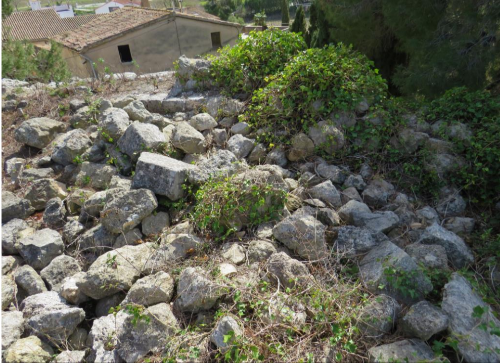
Figura 14. En l'enderroc superior, excavat durant la restauració de 1967-68, encara podem observar carreus escairats corresponents generalment al mur interior del segon cos (Elaboració pròpia).
