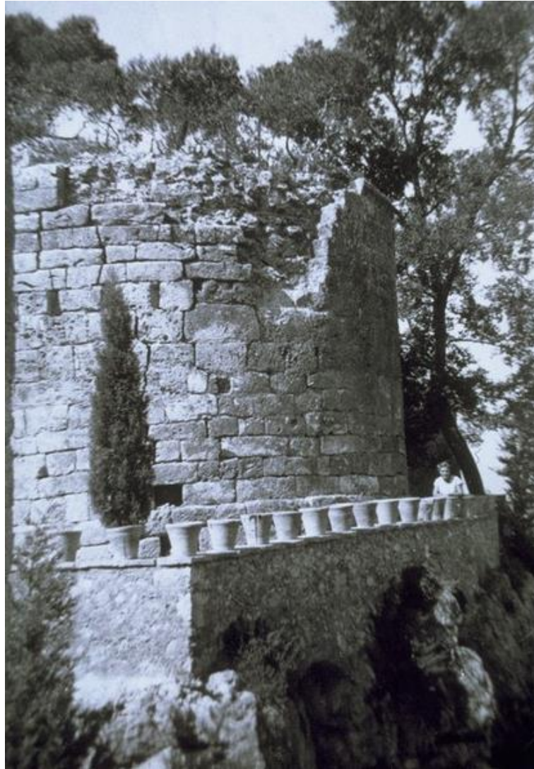
Figura 49. Estat del monument als anys 50 del s. XX -sector NE-, on podem observar part de l'esperó rocós. Fixant-nos en l' opus caementicium , a dos filades sota la cornisa, s'entreveu l'empremta de canvi entre el nucli intern i el morter corresponent al mur del segon cos (Fotografia inèdita cedida per Ignacio Umbert Millet, dins de l'arxiu particular de la família Umbert).
