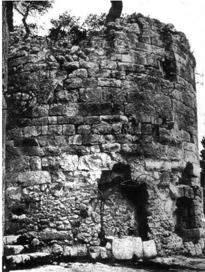
Figura 68. Fotografia anterior a la restauració dels anys 1967-1968, on es poden observar les dues grans perforacions i una sèrie de paraments de contenció -pedres petites i morter-, desmuntats durant la restauració. (Ribas, 1967, 279).
