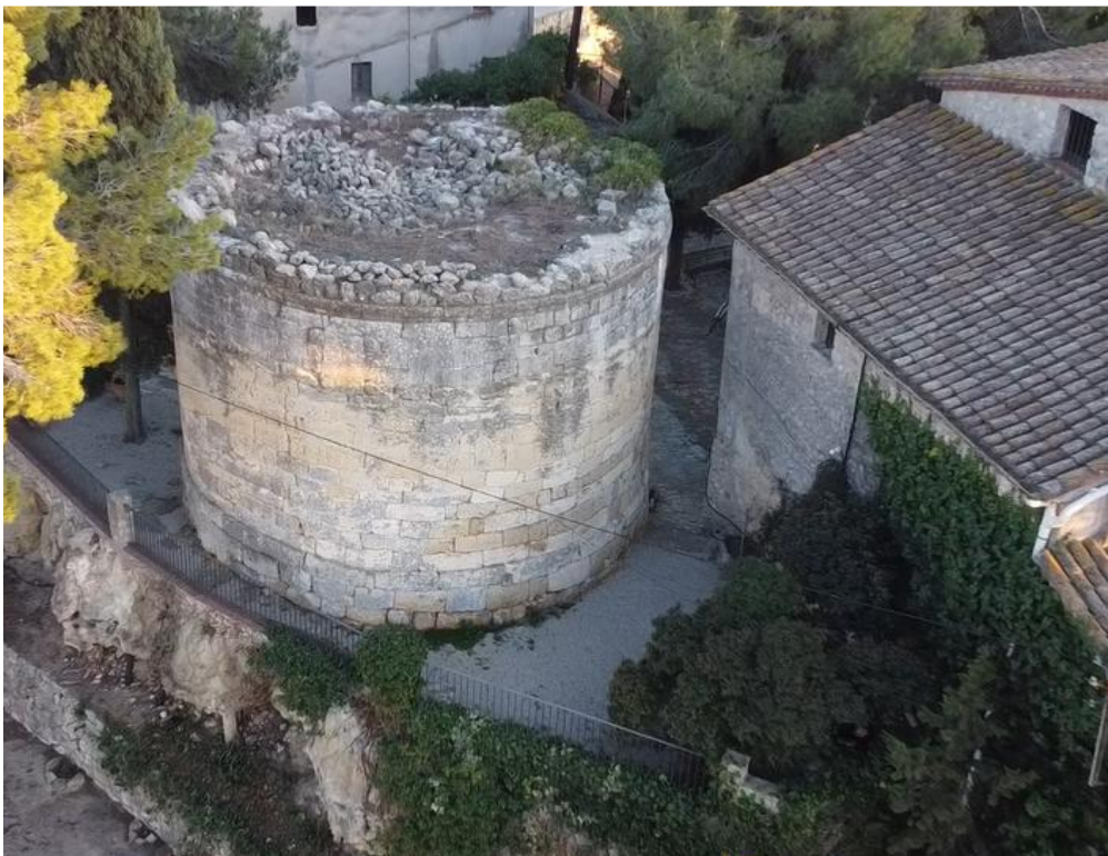
Figura 78. Captura d'un dels vídeos realitzats en dron, on es pot observar la configuració de la torre vers l'esperó rocós (Elaboració pròpia).
