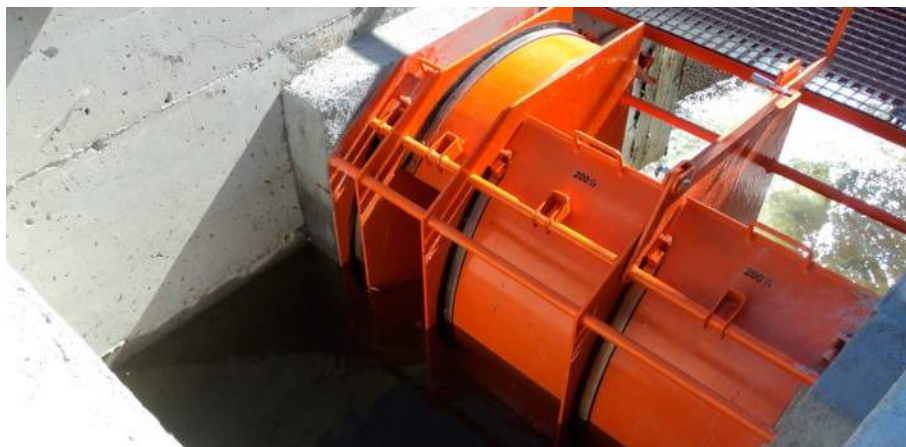
Figura 13: Módulo de máscaras. Las dos máscaras de la derecha tienen un caudal de 200 L/s cada una. Fuente: Ingesur .
