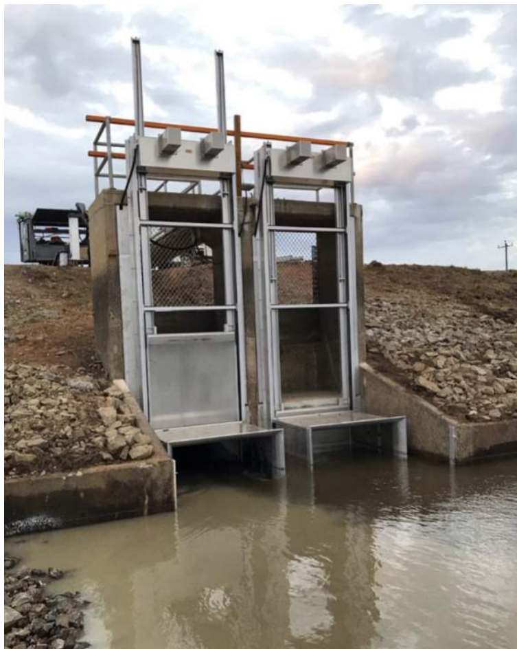
Figura 71: 2 SlipMeter™ en paralelo operando semisumergidas. Fuente: Rubicon Water
