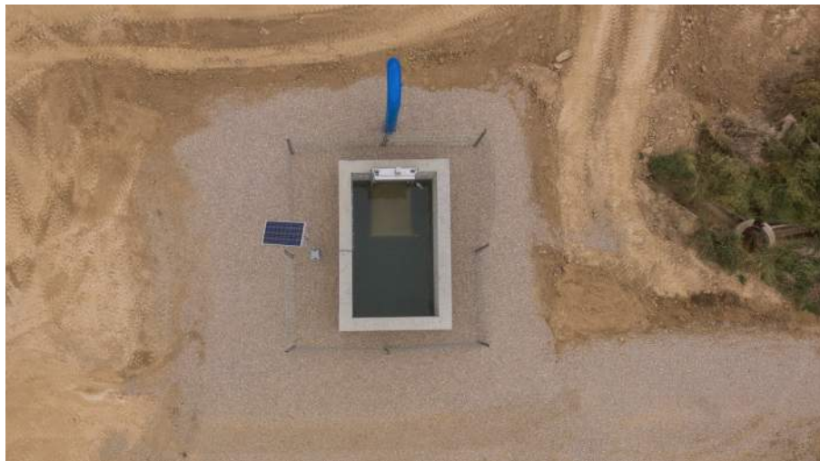
Figura 10: Vista cenital de una SlipMeter™ instalada y en funcionamiento en el sistema del Canal del Flumen, Aragón. Fuente: Rubicon Water y Regaber
