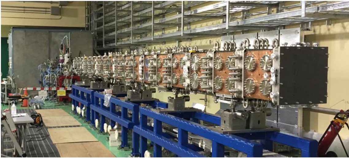
Figura 17. Instalación del RFQ en Rokkasho. (Fusion FOr Energy, s.f.)
