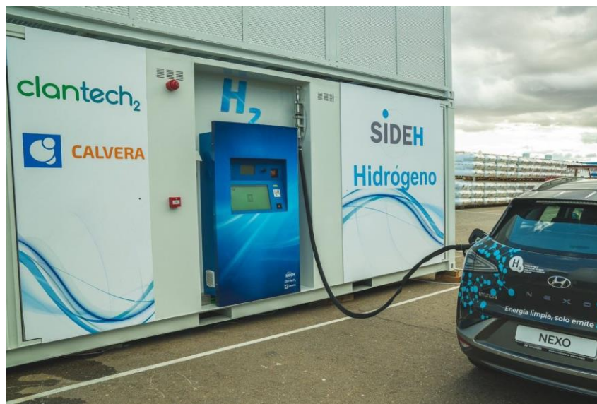
Ilustración 17: Imagen del surtidor de H2 confeccionado por Calvera S.A.
