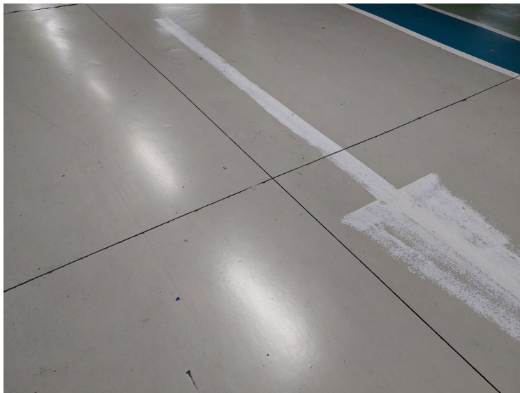
Figura 36. Exemple de juntes de dilatació
