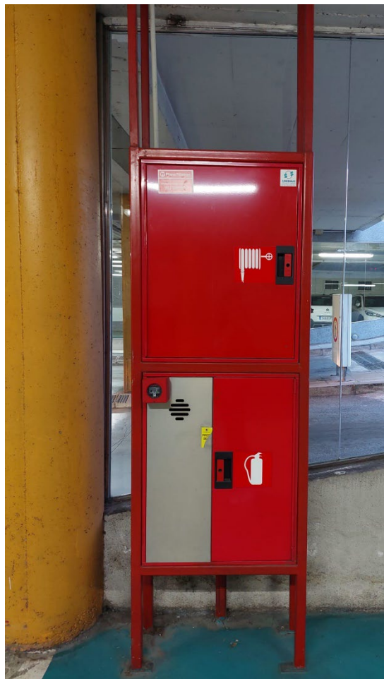
Figura 161. Exemple de mòdul de BIE + extintor + polsador d'alarma col·locat en cadascun dels punts on no pot anar ancorat a la paret
