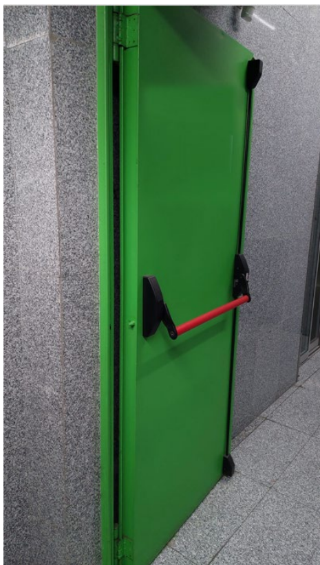
Figura 143. Porta EI 2 60-C5 amb barrera antipànic
