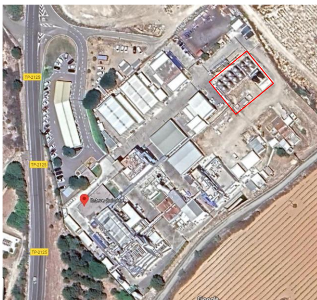
Figura 1. Localización del parque de tanques.
