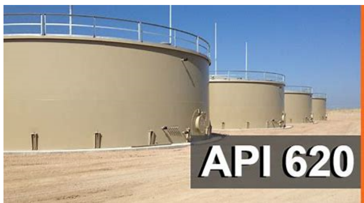
Figura 2.3. Exemple de tancs d'emmagatzematge regits pel codi API620.
