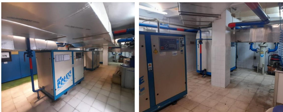
Il·lustració 1. Sala antiga compressors
