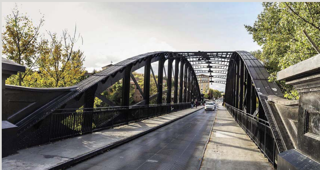
PUENTE COLGANTE , Valladolid - España
