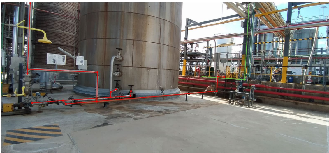
Figura 27: Disposición de las nuevas tuberías tramo bandeja-cargadero.
