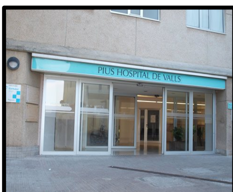
Figura 2: Fotografía de la puerta de entrada del hospital.
