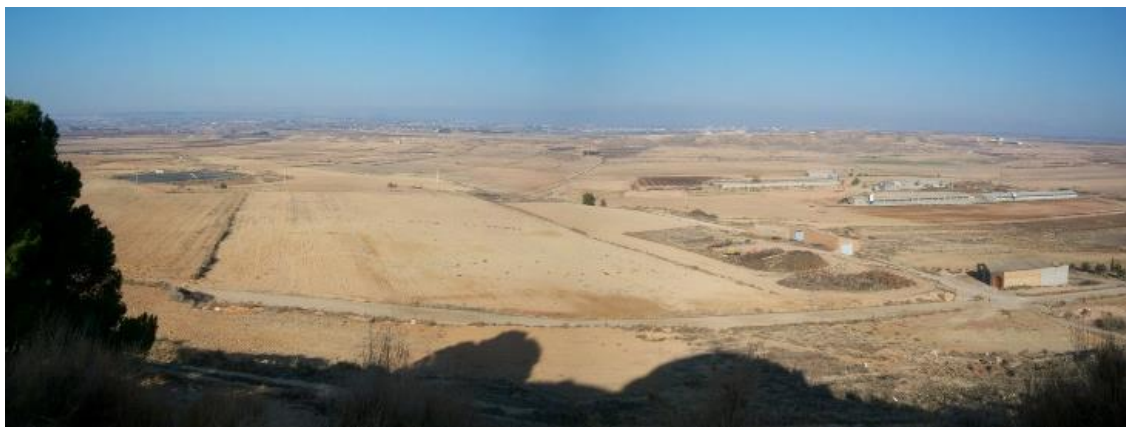
Figura 21: Imatge de les obres de transformació al regadiu (pas d'infraestructures i concentració parcel·laria) al terme municipal de Sunyer (any 2005). Imatge cedida.
