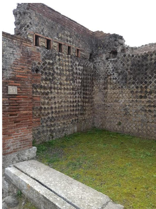
Fig. 45, 46 y 47: Fotografías del interior de tres tabernae en Pompeya mostrando su pericia constructiva (de menor a mayor) y los huecos de vigas que sostendrían el mezzanino superior. Interior de una taberna
