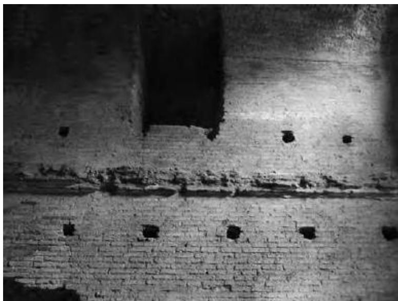
Fig. 15: Huecos de la instalación de un mezzanino en la Ínsula del Aracoeli, Roma. Ippoliti 2015, 187.
