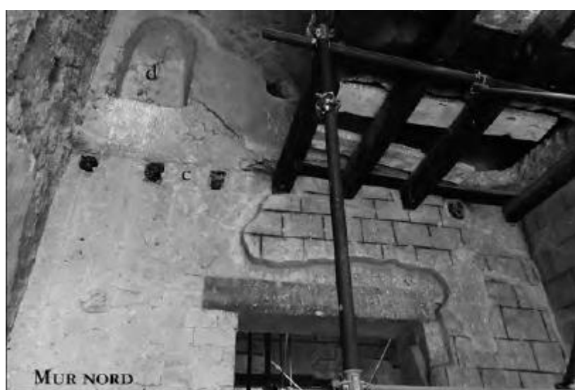
Fig. 26: Ejemplo de un mezzanino parcialmente conservado en la bottega V, 16 de Herculano. De Monteix 2010, 329.
