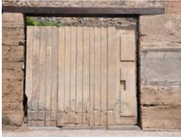
Fig. 23: Molde del cerramiento de las tabernae a modo de persianas (Pompeya IX.7.10). Holleran 2017, 146.
