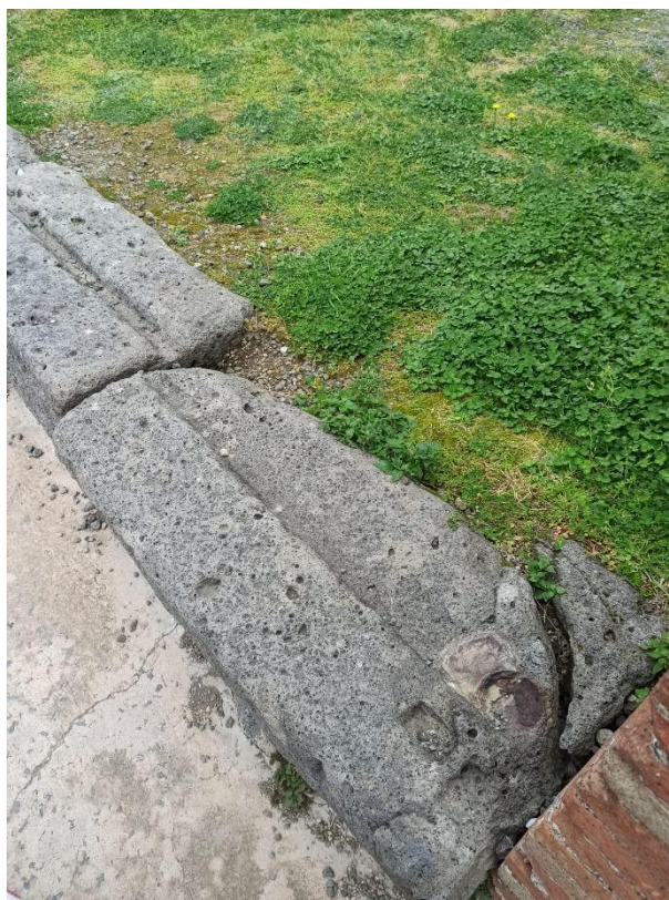
Fig. 24: Detalle del testimonio en los bloques de piedra del sistema de cerramiento en una de las tabernae de Pompeya. Fotografía de I. Guerrero.
