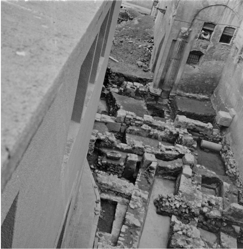
Fig. 18. Imatge de l'excavació de l'any 1971 a la plaça d'en Rovellat on s'observa el recreixement del mur A (fons MNAT).
