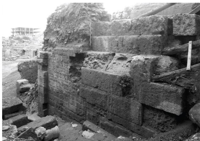
Figura 23. Fotografia de l'accés fet durant els treballs de reconstrucció als anys 60 [TOLDRÀ 2013, imatge 104]
