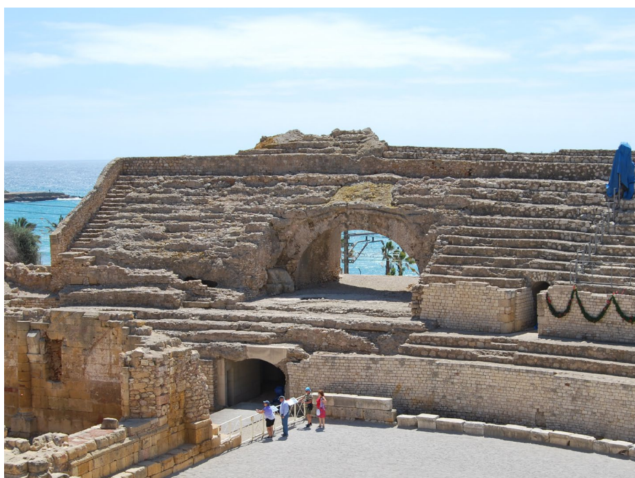
Figura 58. A dalt, proposta de restitució del sector meridional. A baix, fotografia de l'estat actual.
