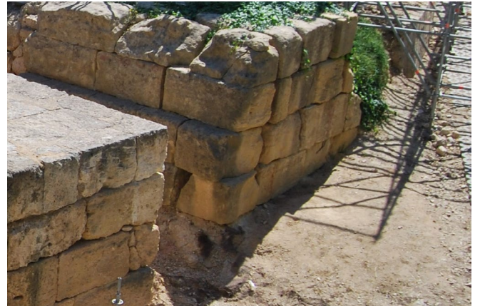
Figura 18. Detall del recolzament del mur meridional sobre la roca mare
