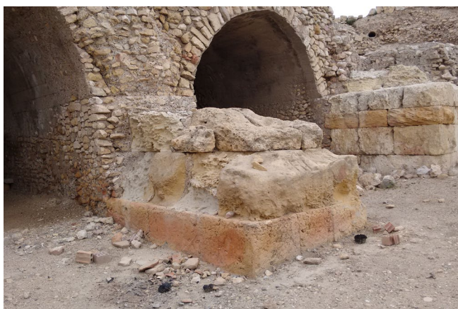
Figura 54. Carreus de l'extrem dels murs radials, pertinents a la part inferior de la façana meridional
