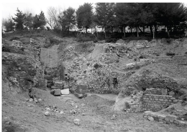
Figura 22. Fotografia de l'accés fet durant els treballs de reconstrucció als anys 60 [TOLDRÀ 2013, imatge 103]
