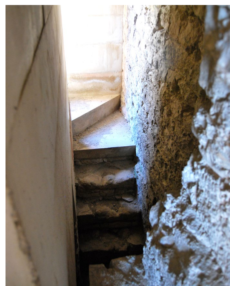
Figura 47. Fotografia de les escales que conduïen a la galeria hipogea
