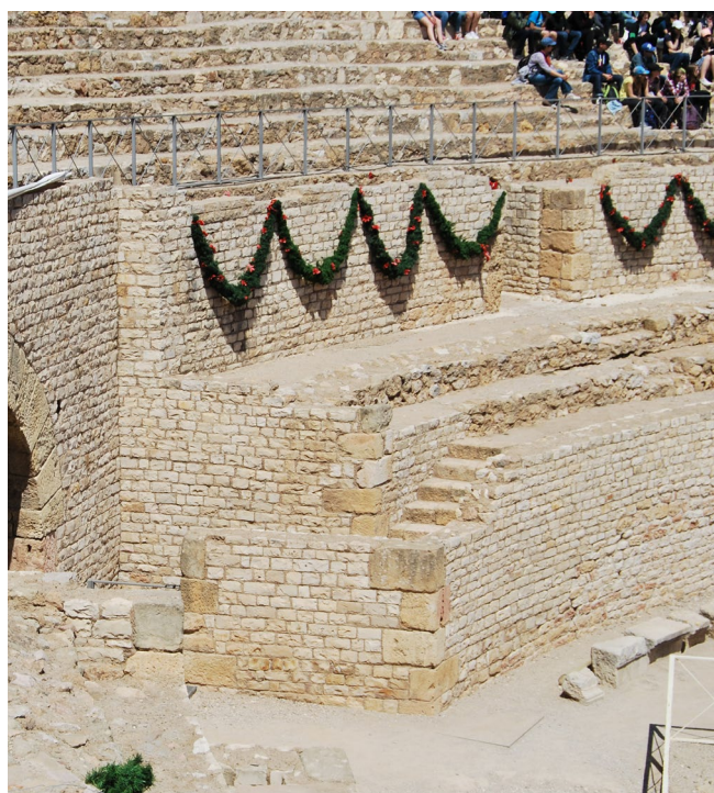
Figura 28. Escales reconstruïdes del sector occidental
