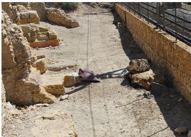
Figura 52. Fotografia de l'extrem inferior del mur que forma la crugia central
