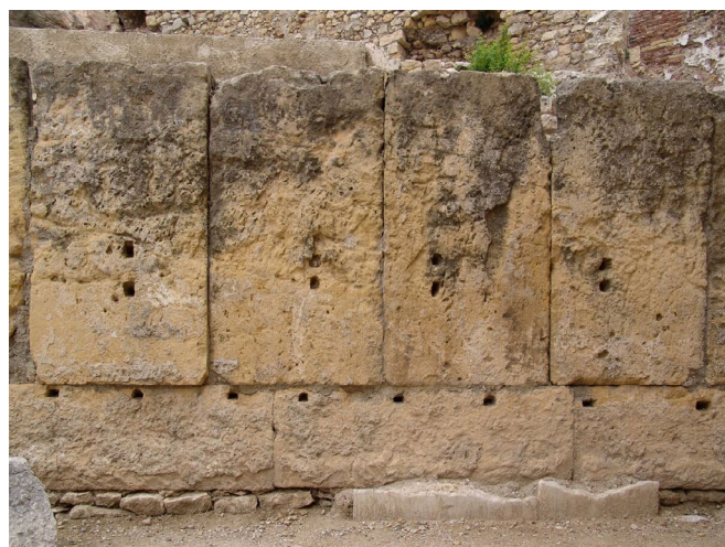
Figura 34. Blocs de pedra de l'estructura del podium, i restes de l'aplatat de marbre en la part inferior i en les incisions on anaven les grapes de subjecció
