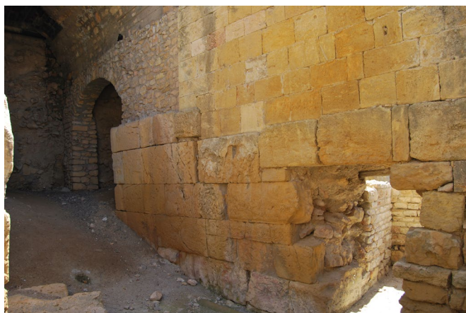
Figura 25. Galeria d'accés a l'arena al costat oriental
