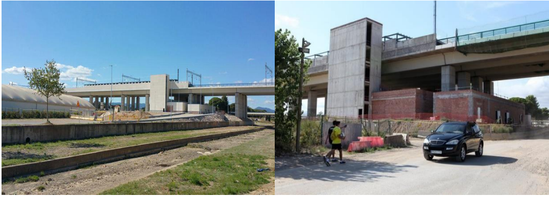
Figura 5. Construcció de la nova estació. Font: Ajuntament de Cambrils, 2018
