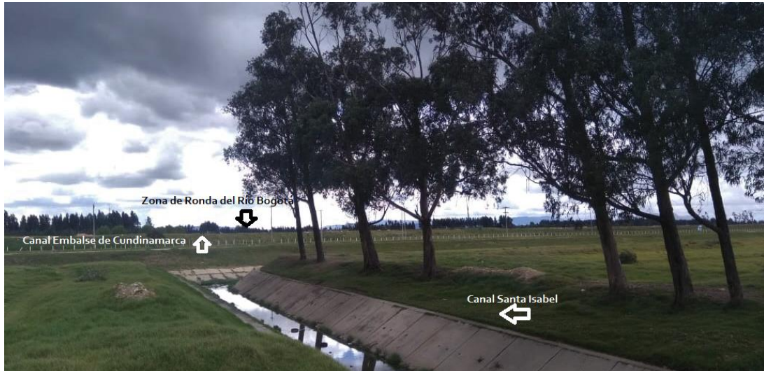
FOTOGRAFÍA 2 ENTREGA DE AGUAS CANAL SANTA ISABEL AL CANAL EMBALSE DE CUNDINAMARCA
