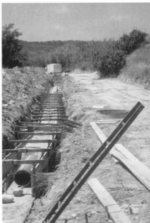
Imagen 6. Colector de aguas residuales construido en el cauce del río
