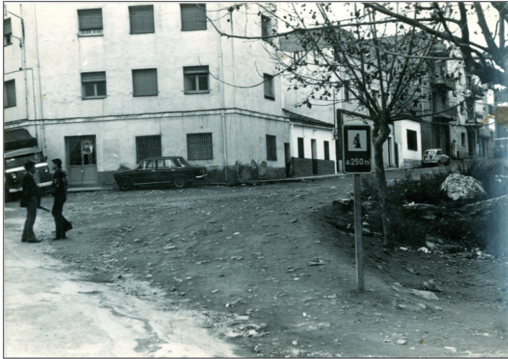
Carrer sense asfaltar, Torreforta. Anys 70. Autor desconegut. AHT.
