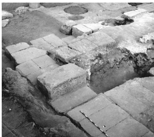
Figura 8. Ángulo NW de la curia, con el arranque del cimiento del muro que separaba el vestíbulo y el aula (a la derecha).
