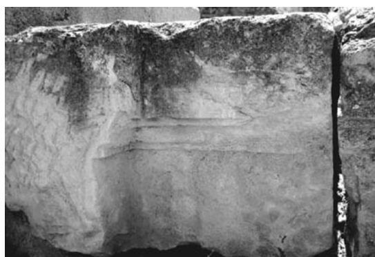
Figura 7. Bloques de la cornisa perimetral del vestíbulo.
