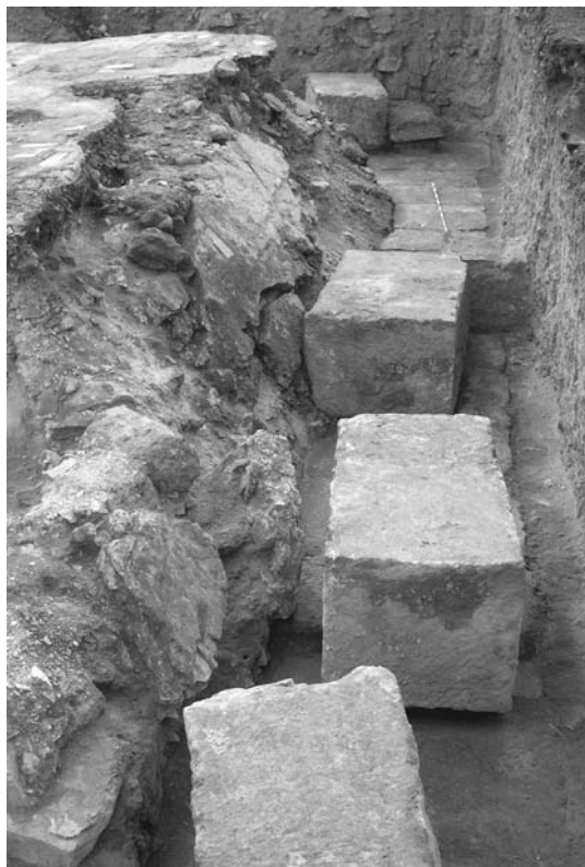
Figura 11. Cimentación del lienzo occidental de la curia, con los sillares de la primera hilada in situ y varias piezas ya removidas y preparadas para ser extraídas durante el proceso de expolio.
