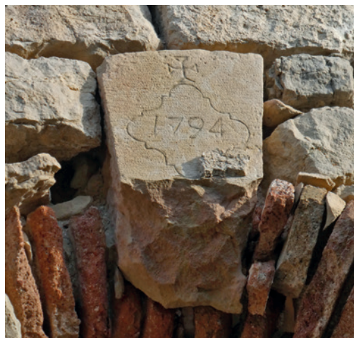
Figura 22. Clau d'arc reaprofitada a l'ull de bou de la façana, any 1794.
