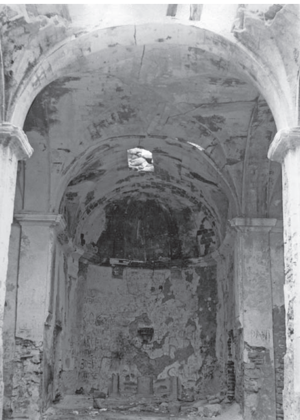
Figura 24. Imatge de l'interior del temple que mostra la coberta amb voltes d'aresta i l'absència de cimbori (© Centre de la Imatge Mas Iglésias de Reus / Claudi Arnavat Vilaró).
