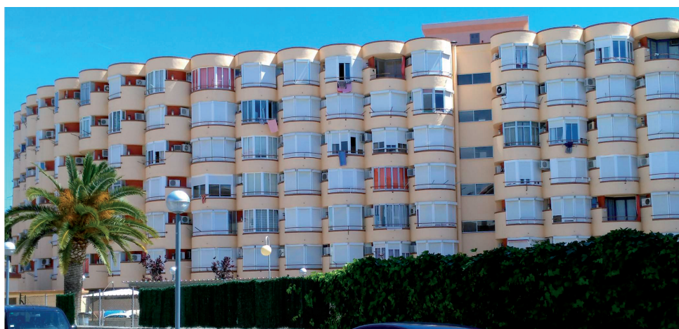
Figura 4. Edificios de apartamentos en La Pineda. Fuente: Autores.
