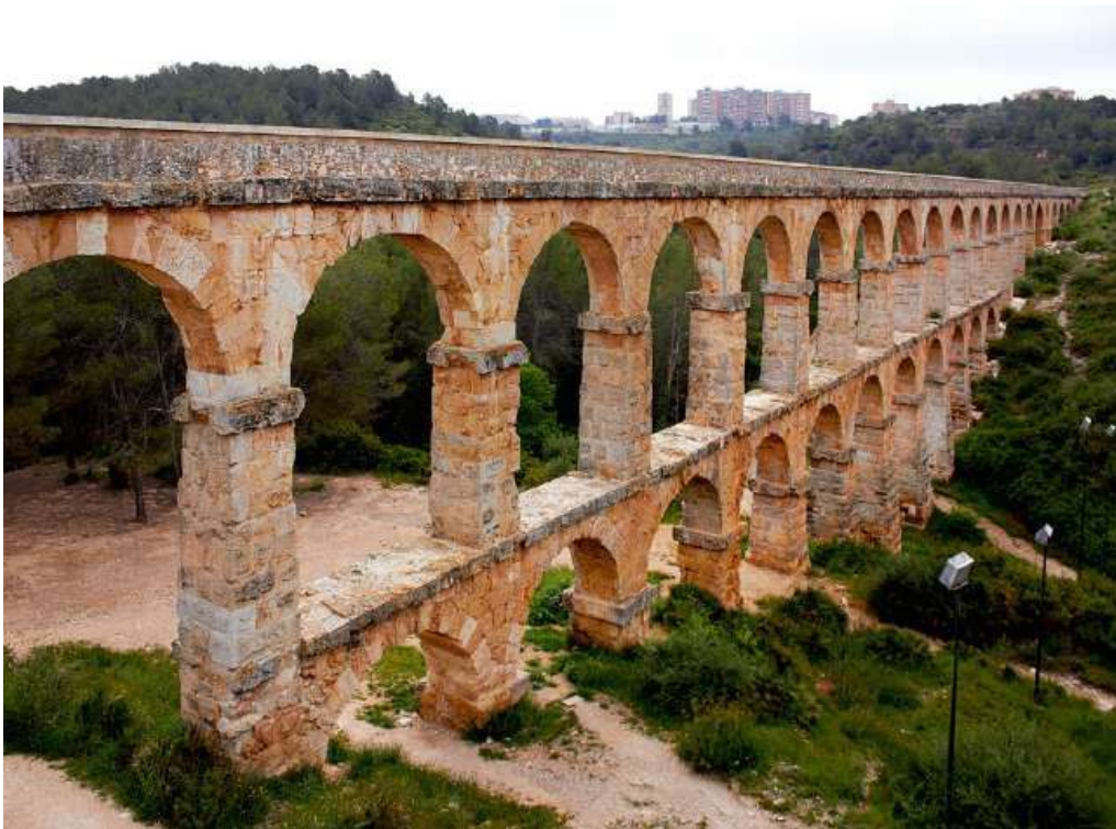
Figura 22. Vista del acueducto del Pont de Les Ferreres. Foto Pepo Segura.
