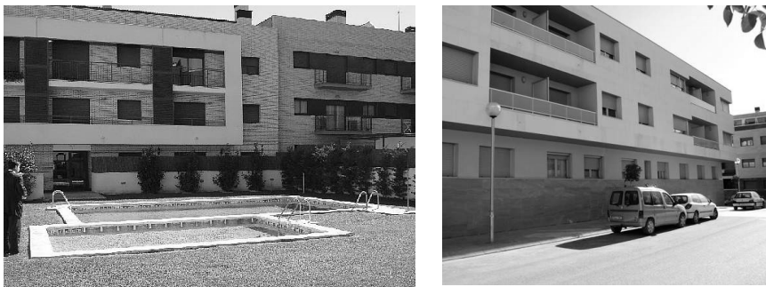
Figura 5 - Promoción de viviendas en edificio plurifamiliar con piscina y espacio colectivo ajardinado en Alcoletge (izquierda), y edificio plurifamiliar con 37 viviendas en Albatàrrec (derecha)
