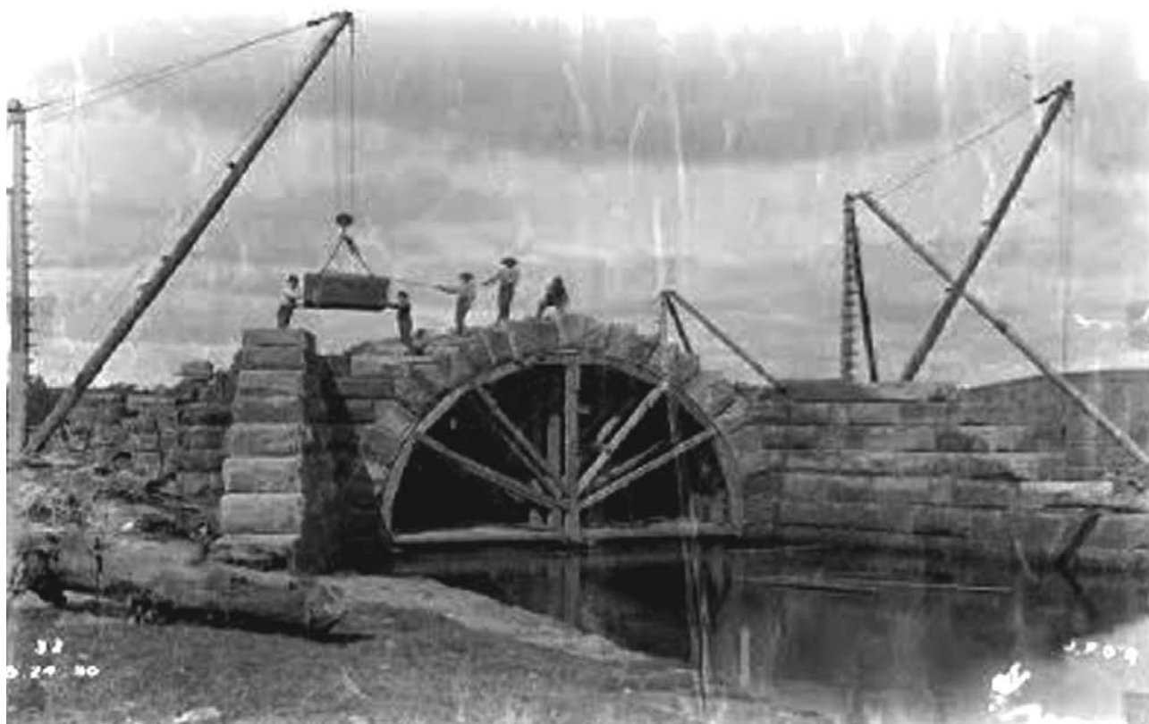
Figura 19. Construcción de un puente en Estados Unidos a finales del siglo XIX. Sorprende la simplicidad de la maquinaria y que el transporte de un bloque de 2 toneladas (2 x 1 x 1 m) pueda ser manejado por sólo 5 obreros (11-08-2022: http://arcos25.blogspot.com/2011/09/construccion-de-arcos.html ).
