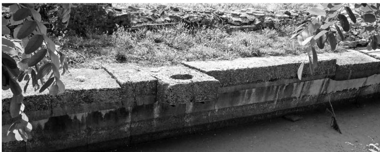
Figura 22. Aquileia. Los bloques perforados en el puerto fluvial del río Natissa.
